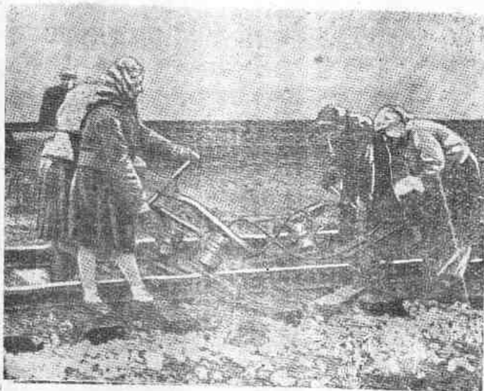
圖8. 在工作时，枕木搗固机由一根枕木移至另一根枕木
