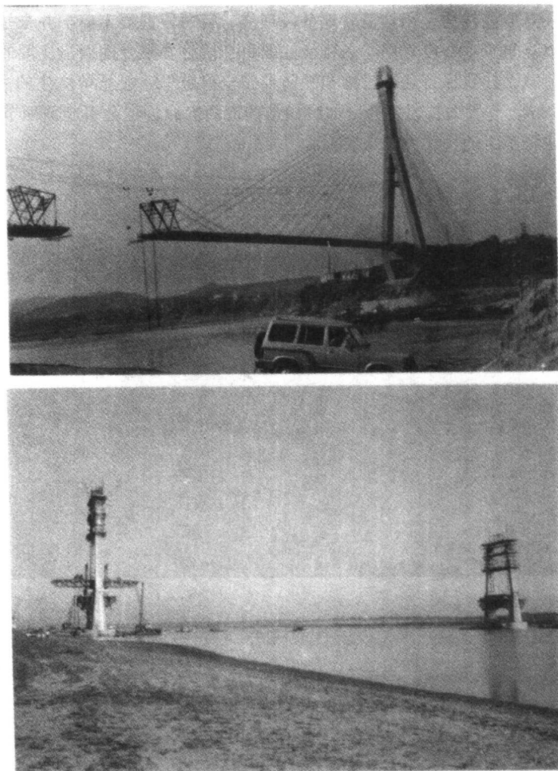
图 1-9 桥梁悬臂拼装施工
