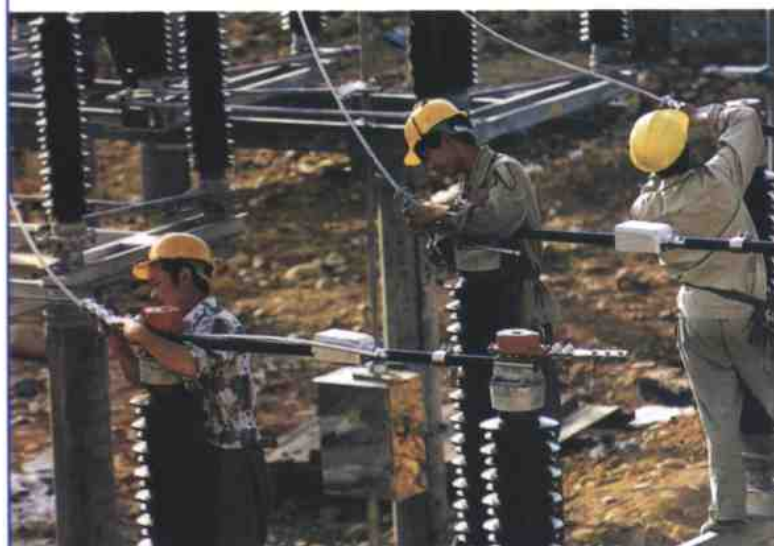
为确保成昆电气化工程顺利开通运行，工程总公司加大管理力度，高效优质推进各项工程施工进度。
