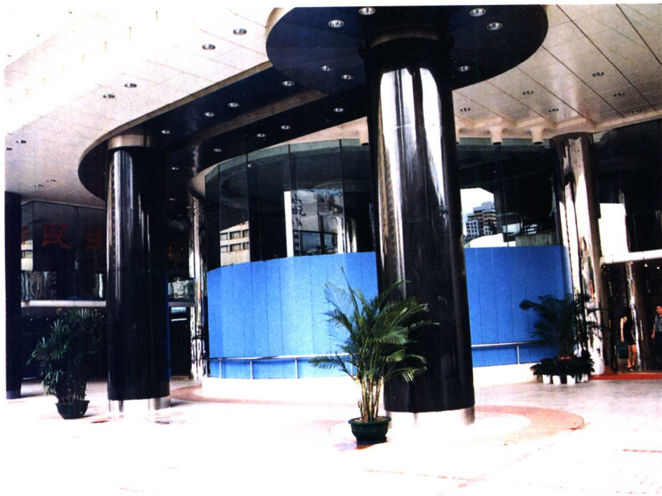
彩图 12 “好世界” 首层正门钢管高强 混凝土柱
