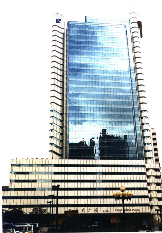
彩图 11 广州好世界大厦，建筑总高度 113.70m， 地下 3 层、地上 35 层
