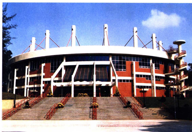
彩图4 华南理工大学文体中心， 工程总建筑面积约 6000 m 2 ，四周环形看台设座位 2475 个
