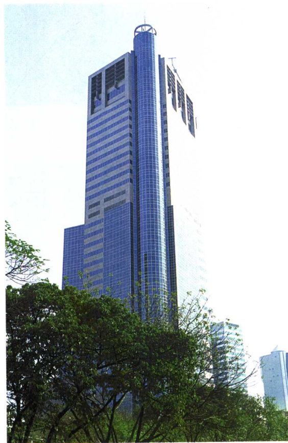
彩图 13 广州国际电子大厦，建筑总高度 168m，地 下 3 层、地上 35 层
