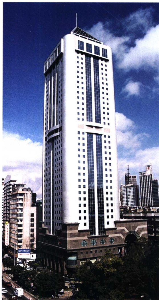
彩图10 广州广发金融大厦, 建筑总高度141.50m, 地下3层、地上41层
