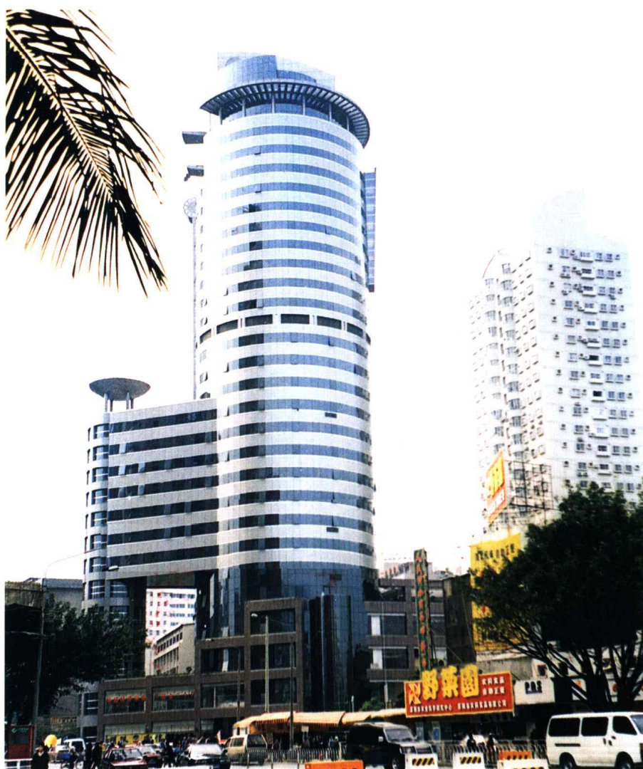
彩图20 深圳市电影大厦全景，主楼高度107.4m，地下室2层、地上30层
