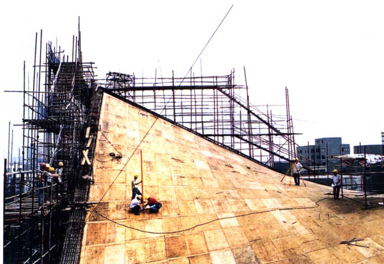
彩图3 音乐厅壳体底模板安装完毕标高复测
