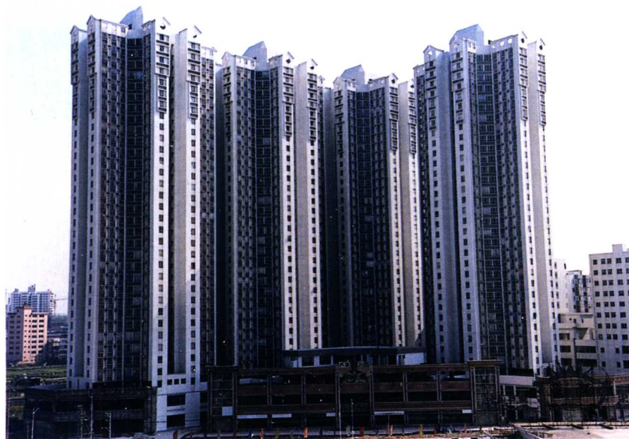
彩图 19 番禺市侨基花园全景，建筑高度 106.7m，地下 1 层、地上 33 层
