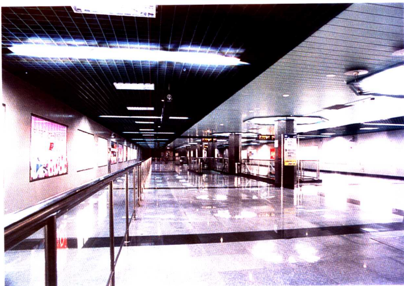
广州地铁一号线陈家祠站站厅
