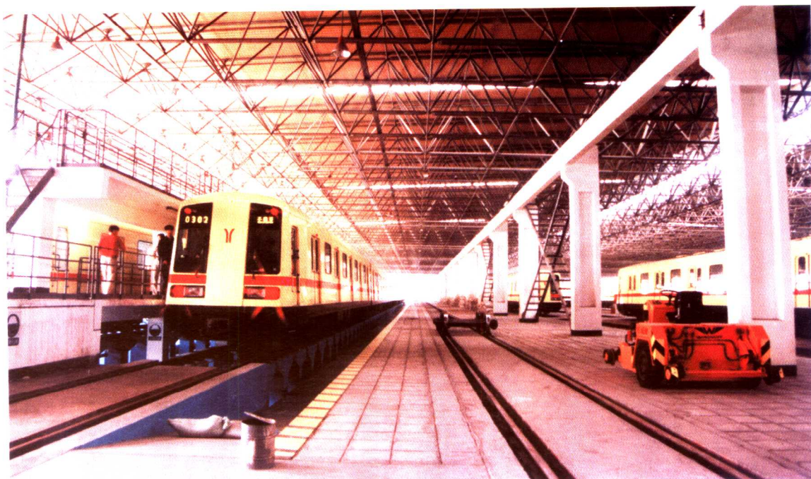
广州地铁一号线芳村车辆段检修库
