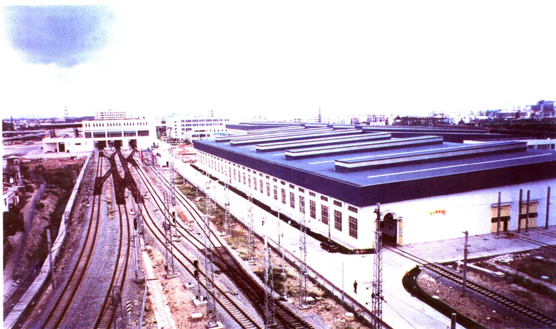
广州地铁一号线车辆段检修库及西廊站
