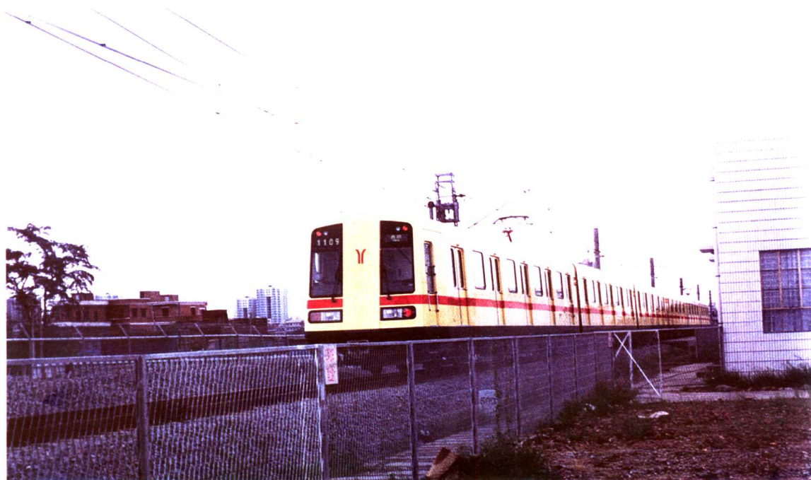
广州地铁一号线车辆段试车线
