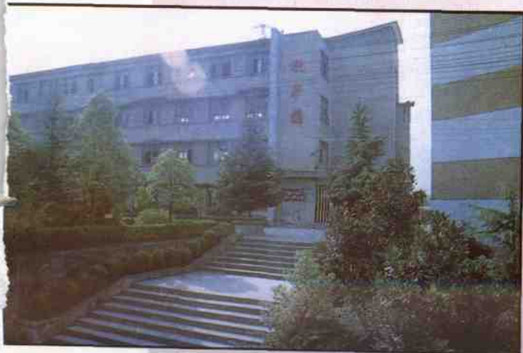
△ 十堰市财贸学校微机教学室
