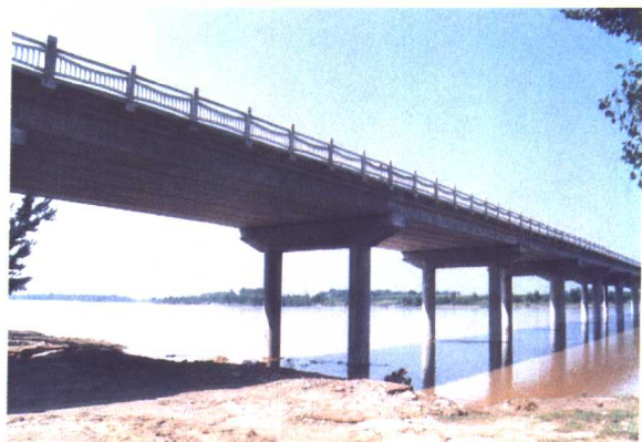
青龙河特大桥
