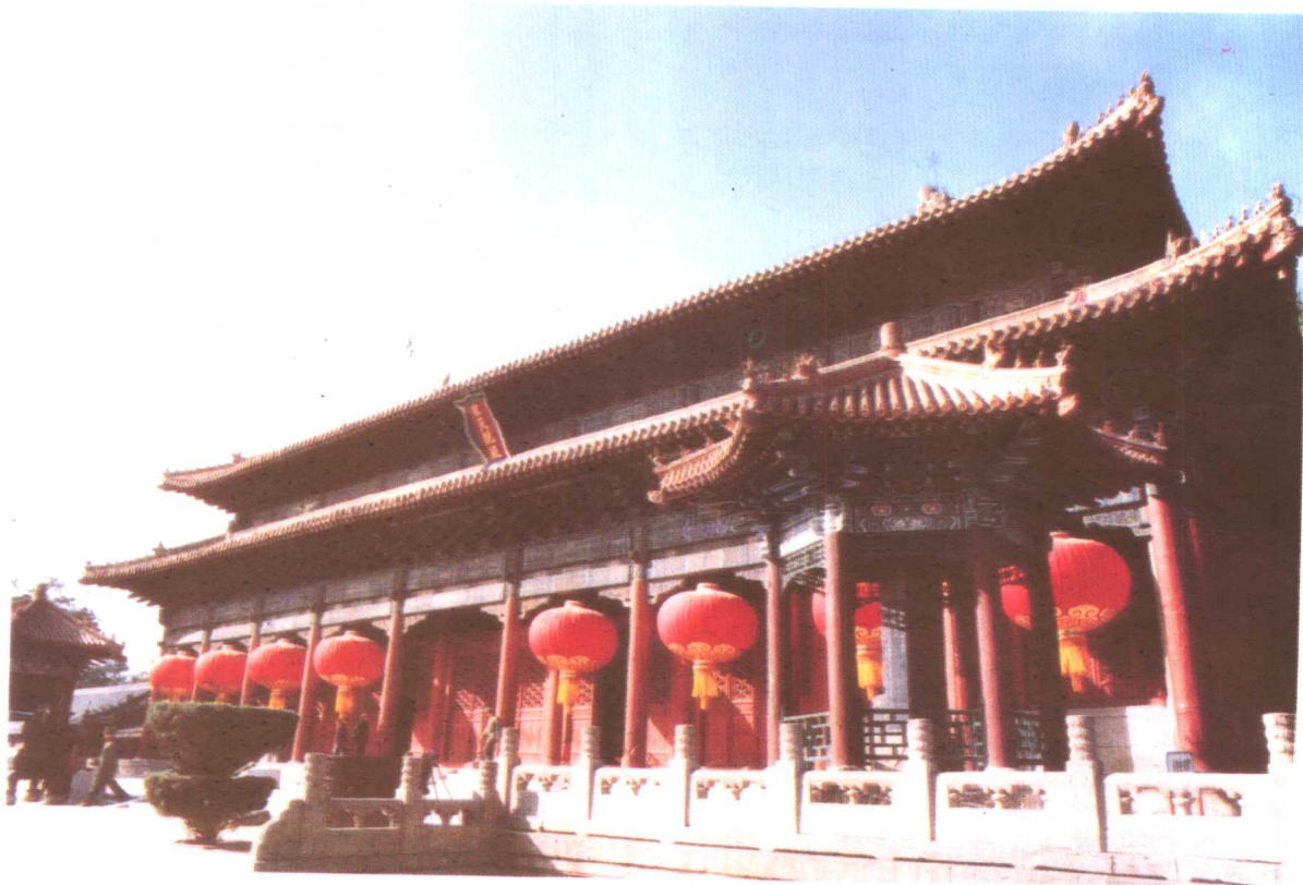
泰安岱庙天貺殿
