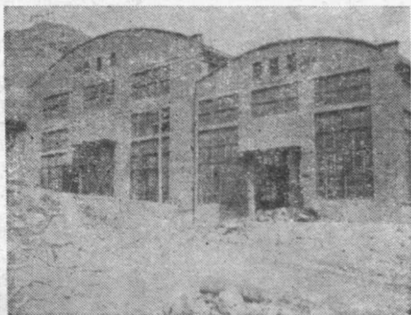
图 1-8 兰州水工机械厂冲剪车间
