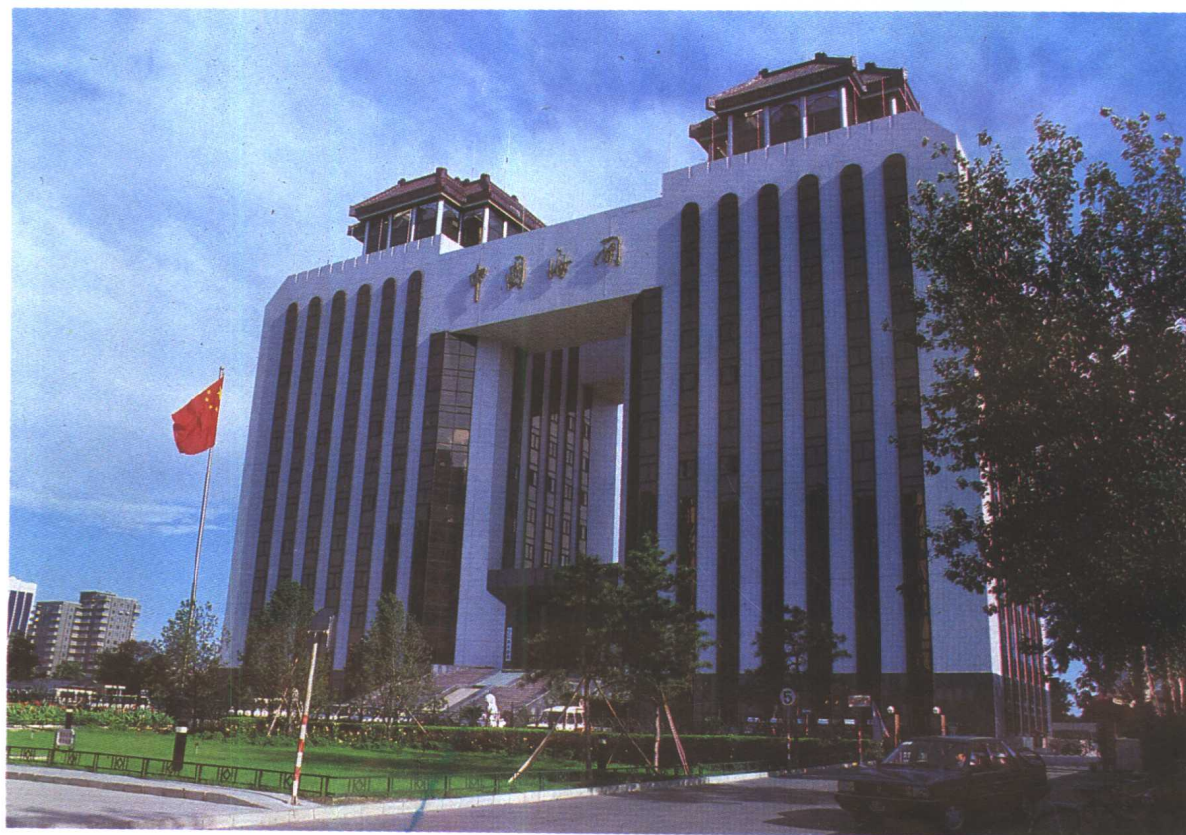
下图 海关大楼
