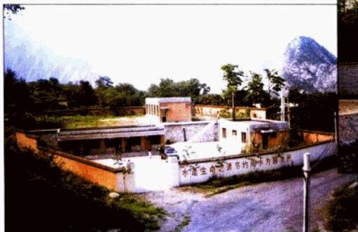
王平地区东八村水厂
