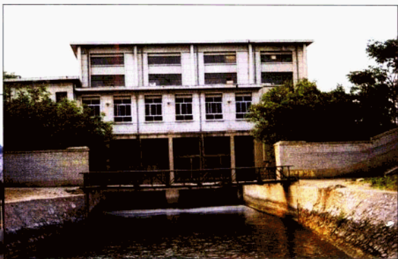
龙泉务水电站
