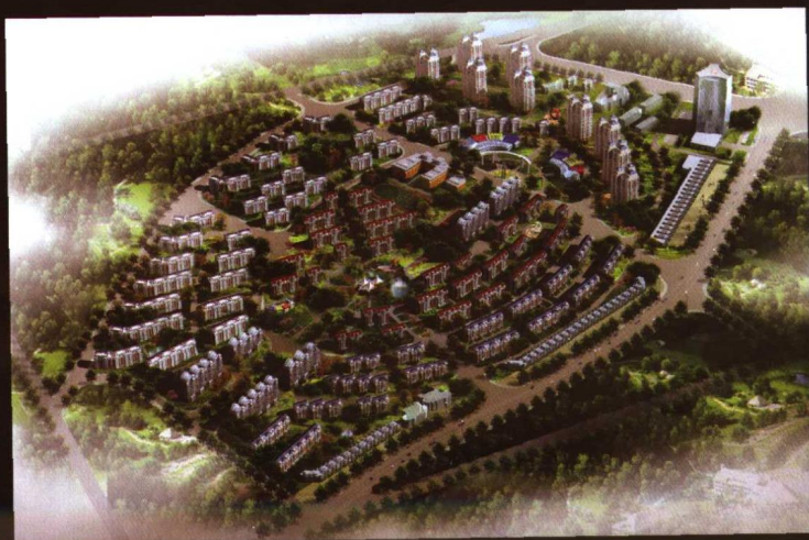
山东头村改造工程
