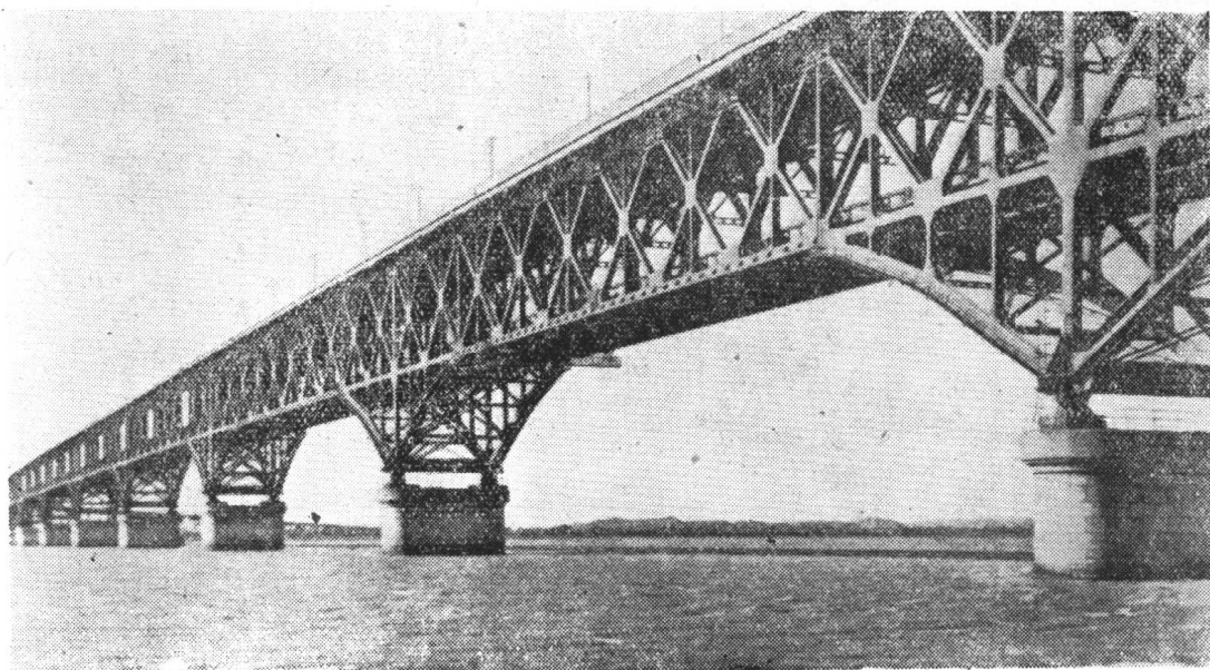
照片 3 南京长江大桥钢桁梁
