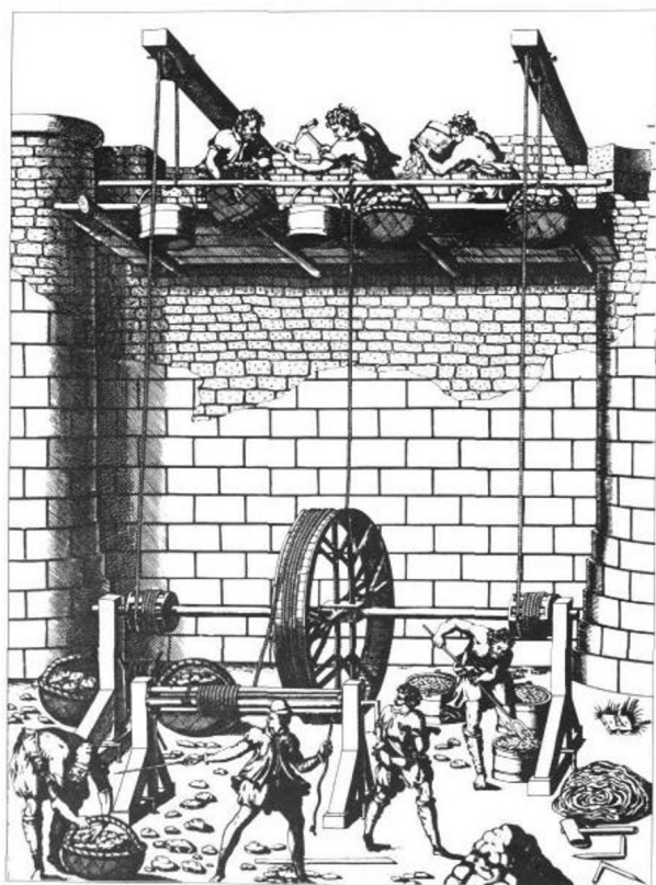
图 1.2 欧洲 16 世纪的施工机械(1569 年的书籍插图)
