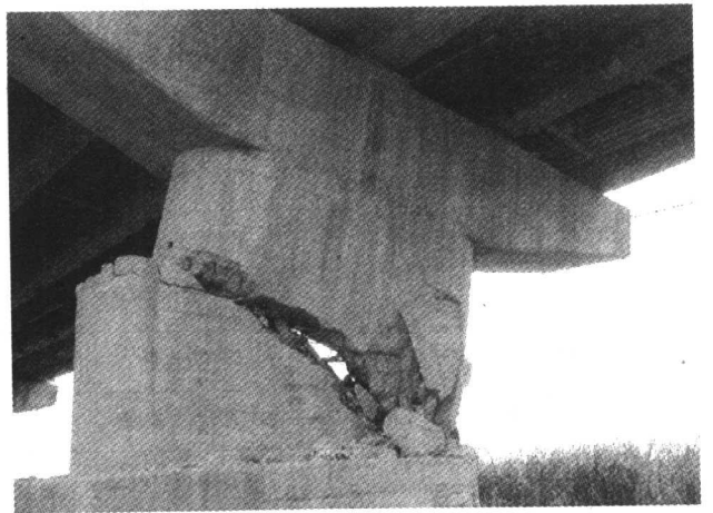
图 1.6 桥墩斜裂缝
