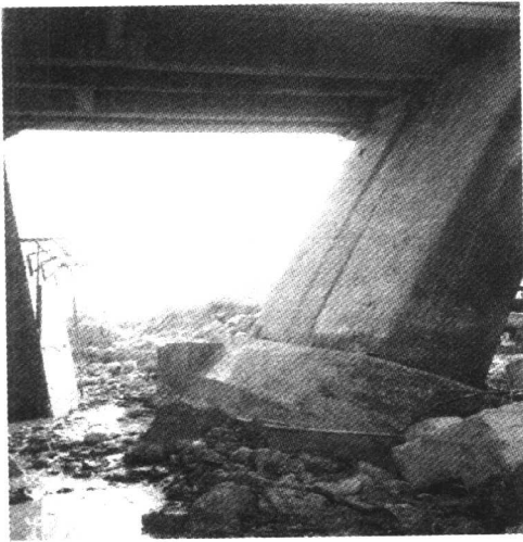
图 1.5 桥梁基础整体翻转
