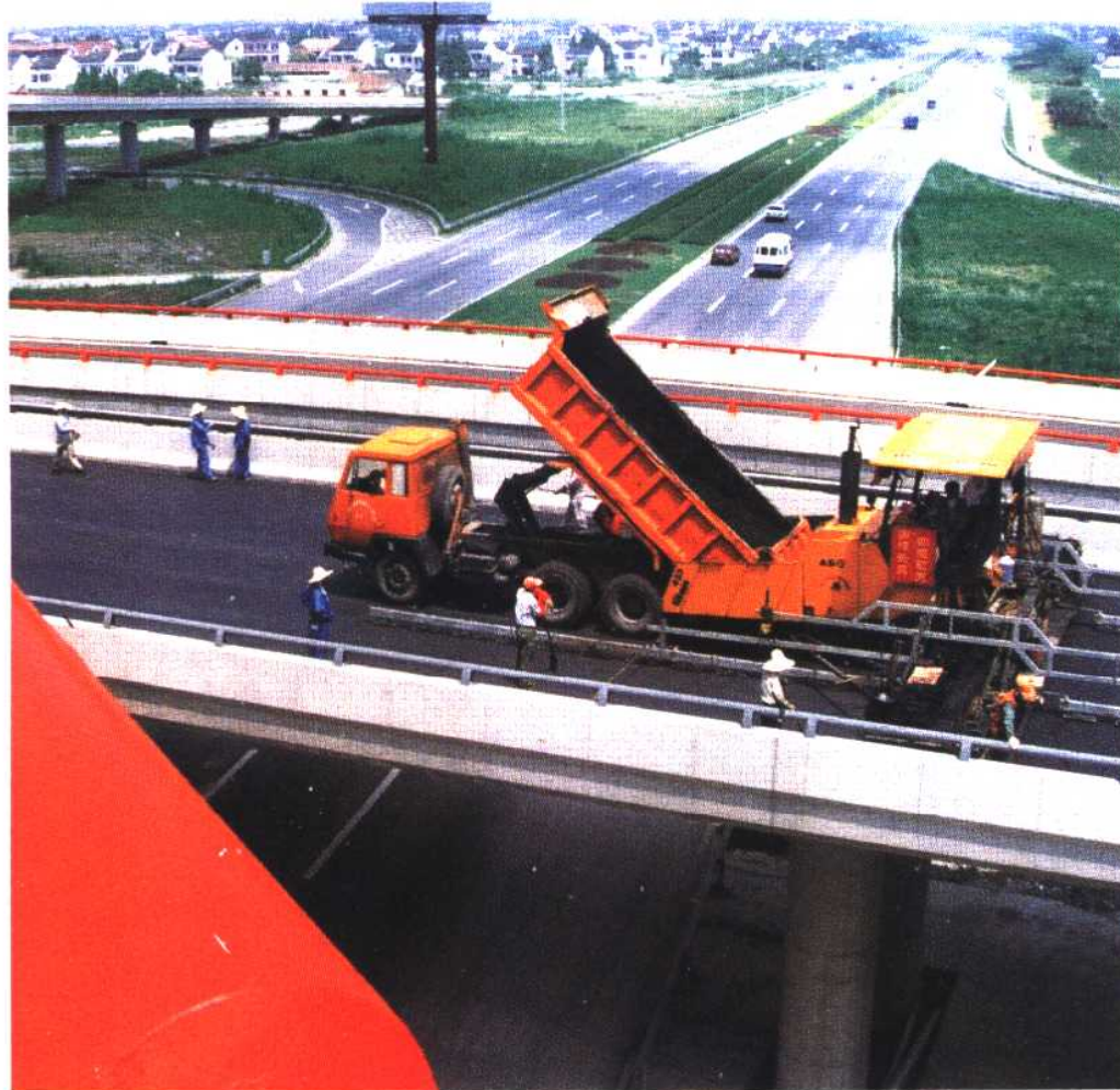
▲ 南干线改性沥青 SMA 摊铺
