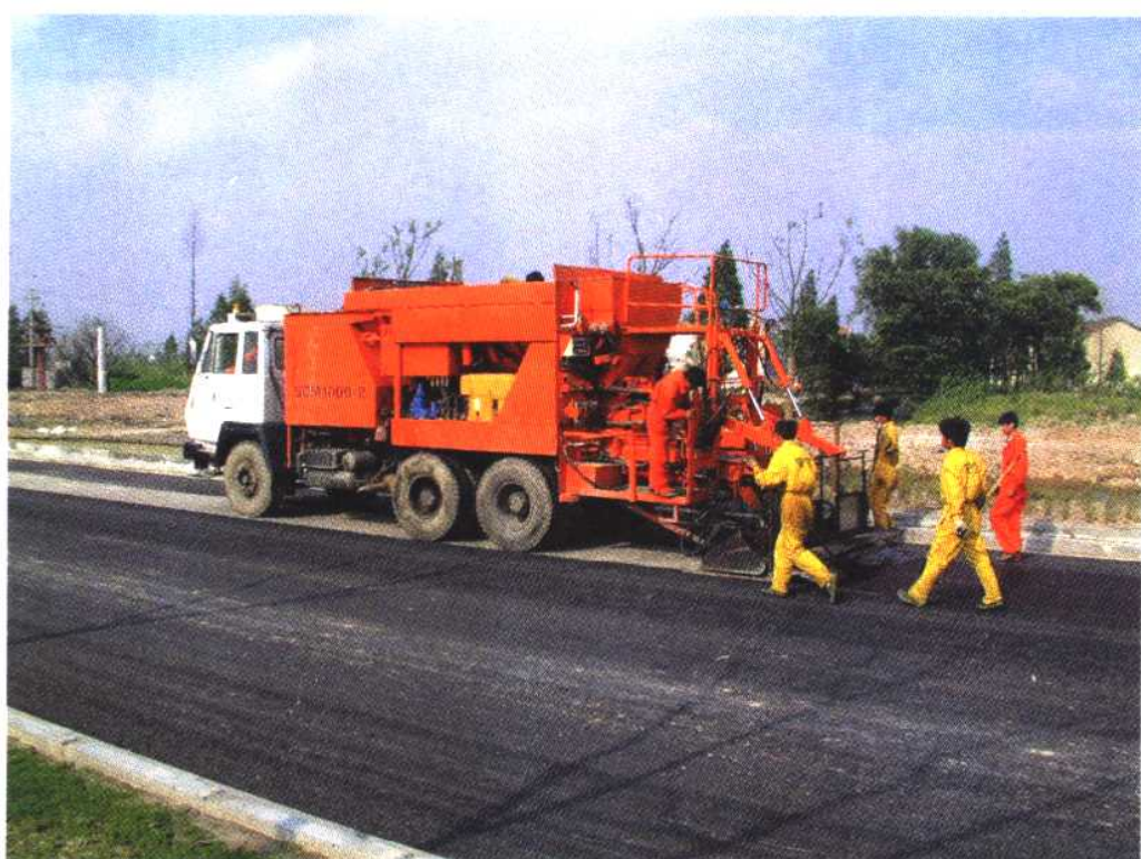
▲ SBR 改性乳化沥青稀浆封层施工
