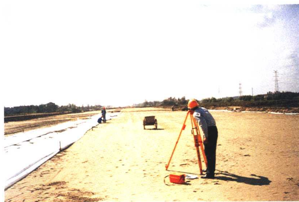
▲ 外环线环东二大道运用新材料长江口细砂作路基，采用“填芯法”施工，周边用土工布包裹
