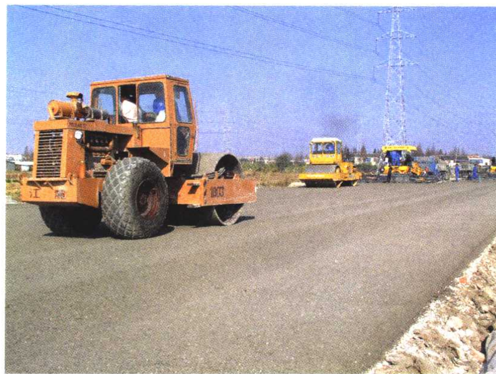
▲ 水泥稳定碎石基层碾压
