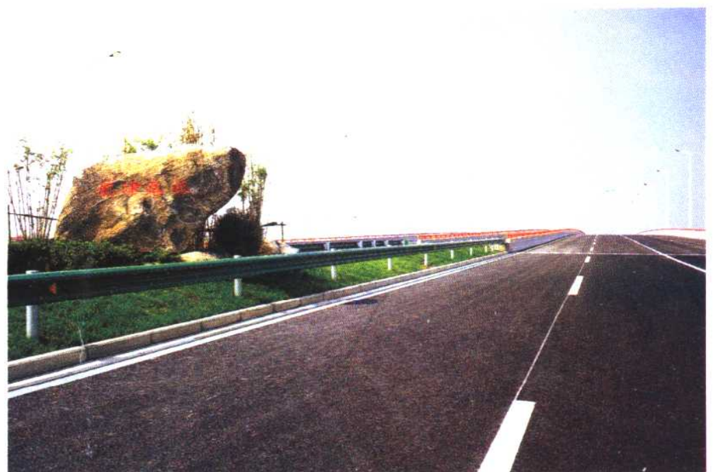
▲ 外环线道路桥名牌别具一格，采用景石示桥点景
