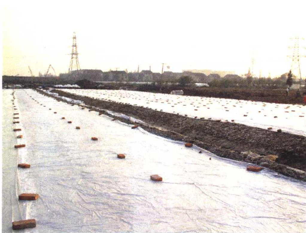
▲ 外环线水泥稳定碎石基层用塑料膜进行养生
