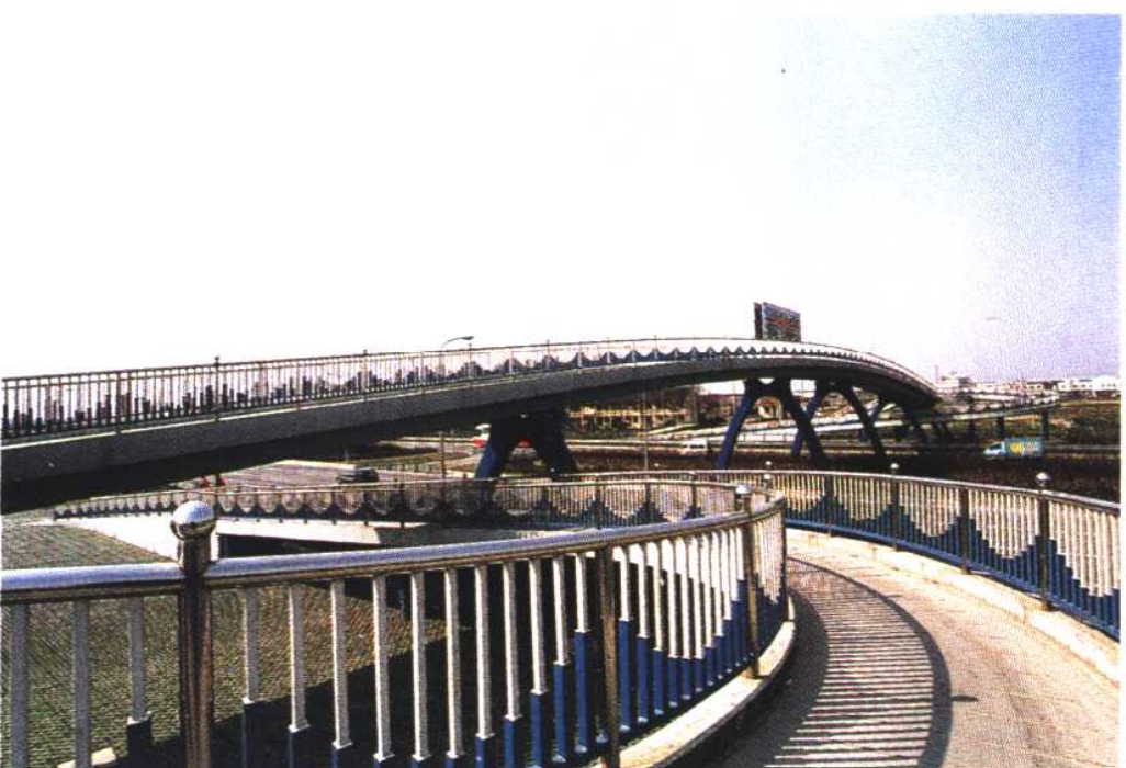
▲ 南干线孙奉路天桥结构精巧、桥墩别致、造型美观
