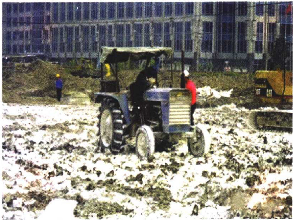
▲ 世纪大道采用石灰稳定瓦砾土土路基
