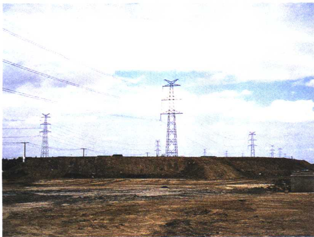
▲ 外环线浦东段在工程开工后首先实施桥坡处理，使桥坡沉降提前发生，避免工后沉降
