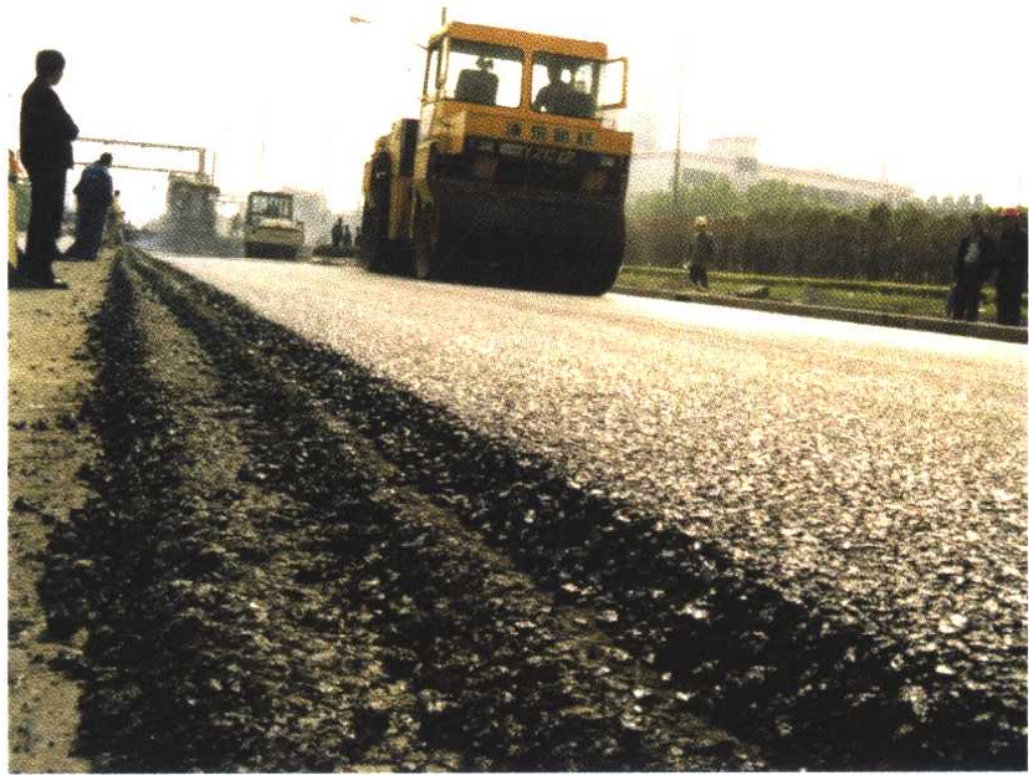
▲ 浦东北路排水性沥青路面试验段摊铺
