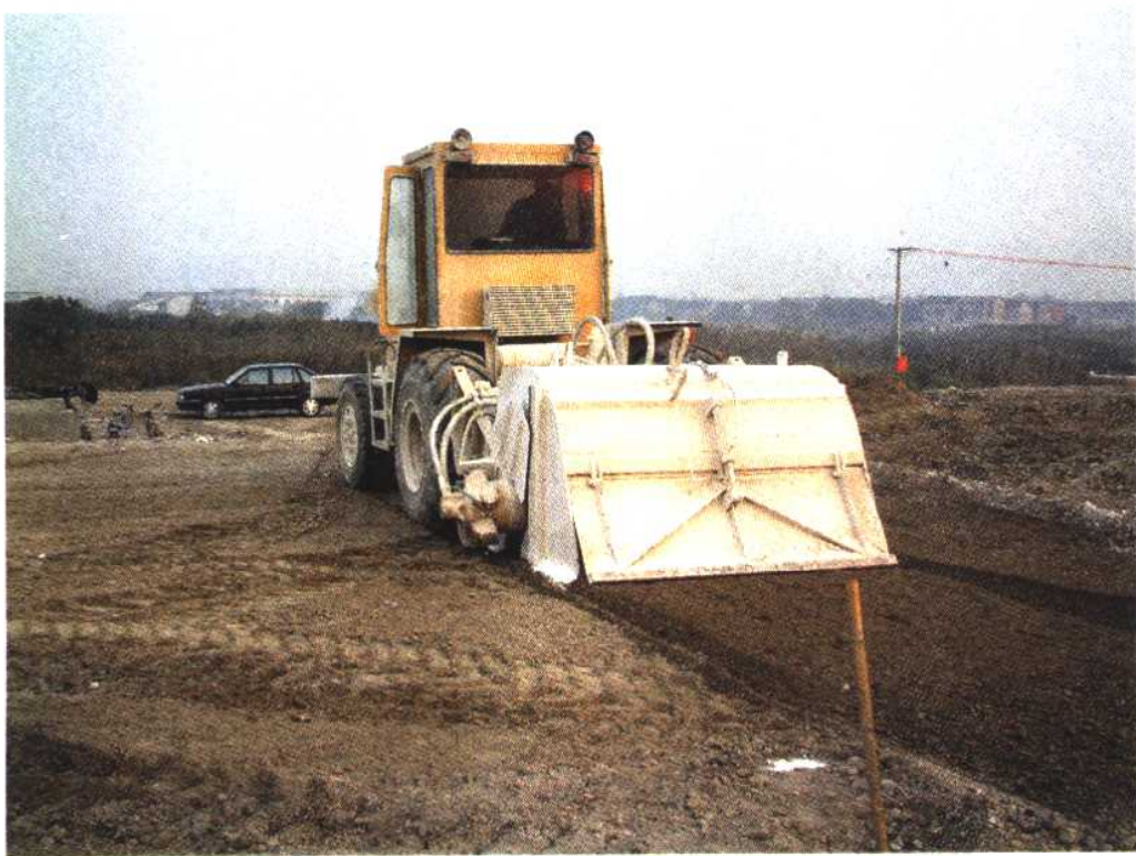
▲ 外环线施工中，采用大型“宝马”路拌机施工石灰土，一次拌和深度可达 30 厘米，使土壤颗粒打得细而均匀
