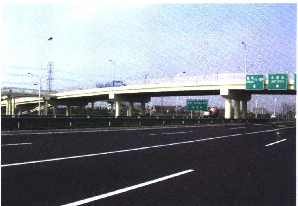
▲ 外环线路线一体化课题研究试验桥——高东二路跨线桥
