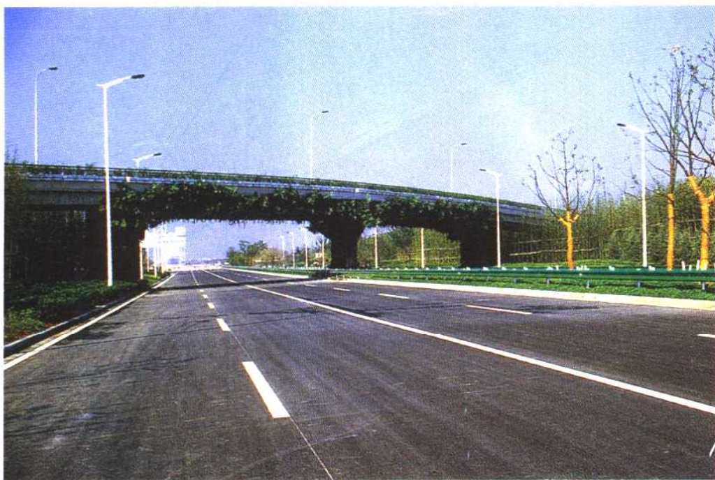
▲ 外环线草高路跨线桥的桥体绿化，营造出“森林之门”的氛围
