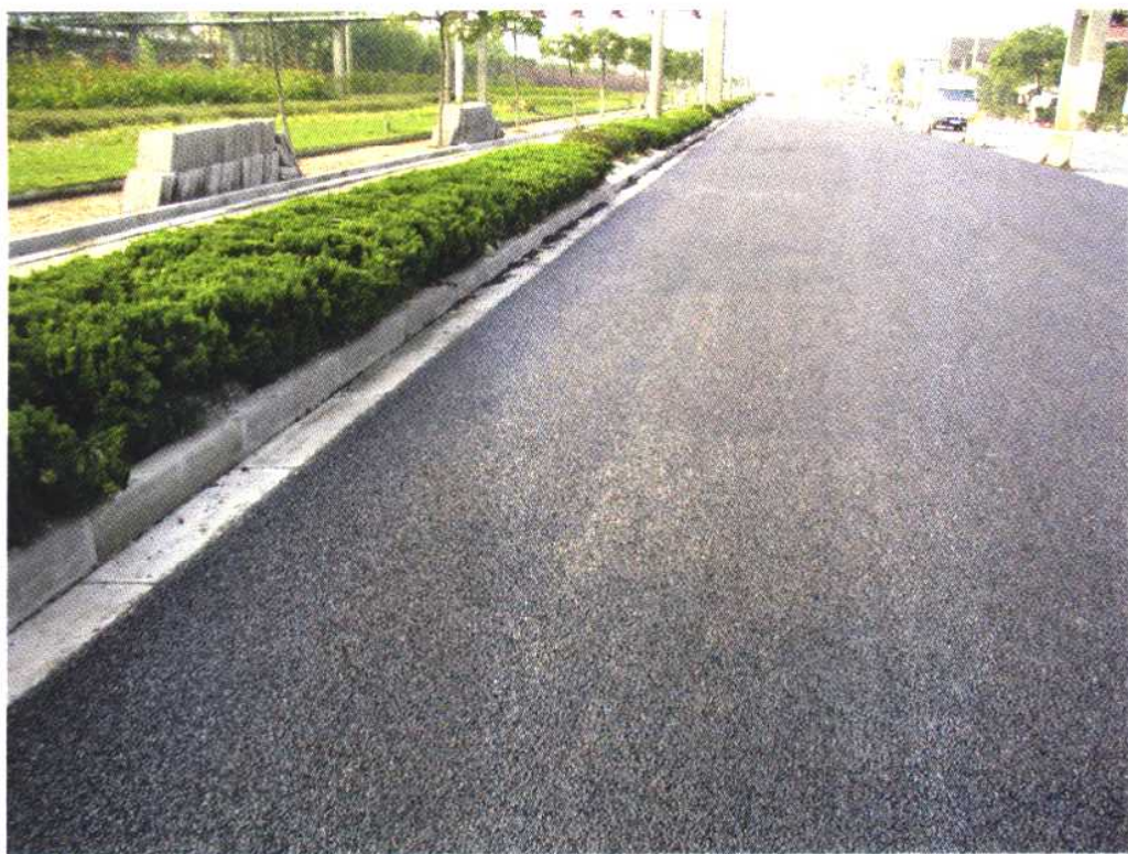
▲ 浦东北路排水性沥青路面试验段
