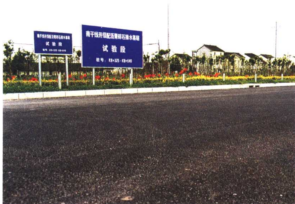
▲ 南干线开级配沥青碎石基层试验段
