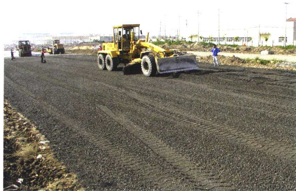
▲ 大型平地机施工水泥稳定碎石
