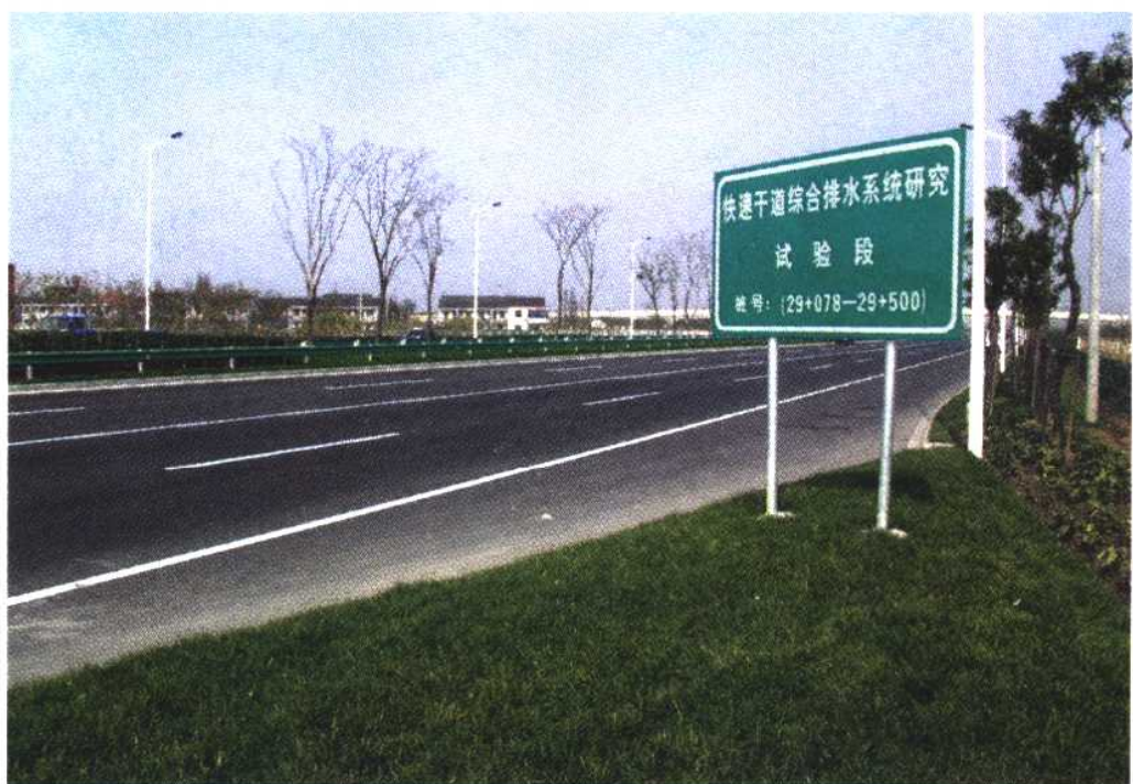
▲ 外环线快速干道综合排水系统研究试验段
