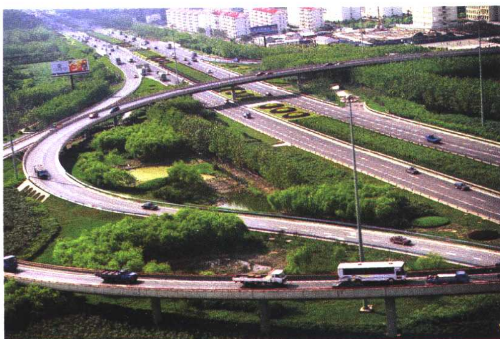
▲ 罗山路延长线环南一大道立交似蛟龙雄踞浦东绿色大地
