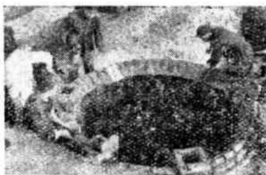
圖 2 南陽紅旗磚窯廠的圓形窯，直徑為 2.5—3.0 公尺 窯高為 3.0—3.5 公尺
