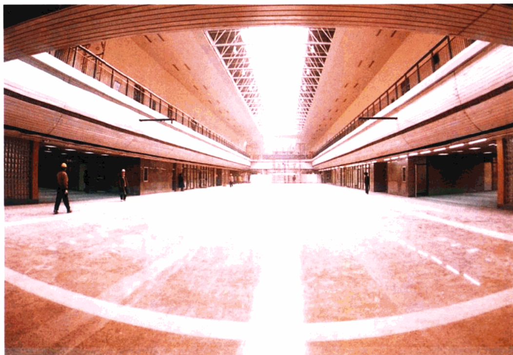
高架候车通廊
