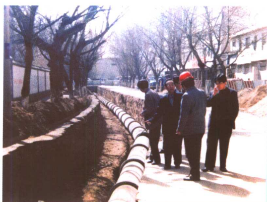
青海省西宁市城区管网改造施工现场
