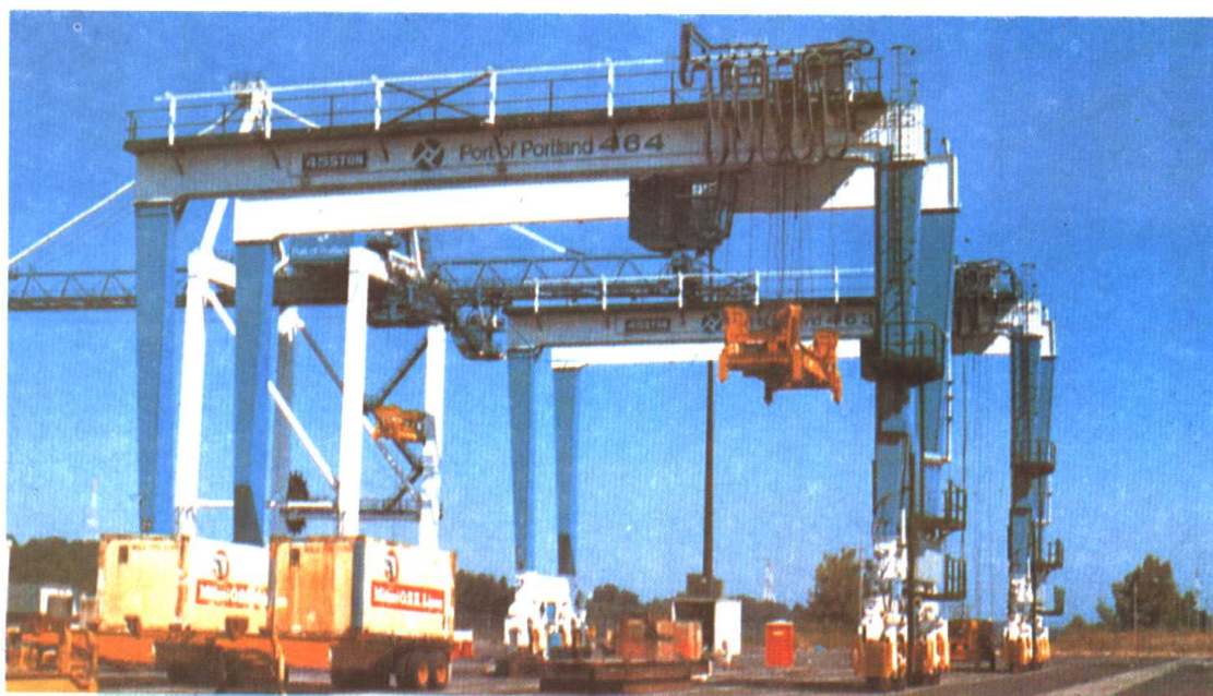
Transfer cranes 運輸起重機
