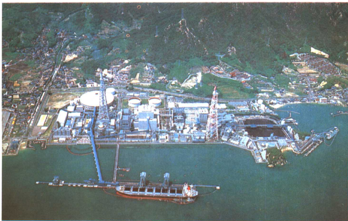
A big thermal power station, Japan 日本的一座大型熱電站
