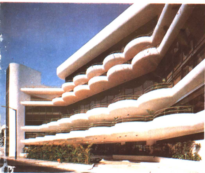
The Hongkong Club 香港俱樂部
