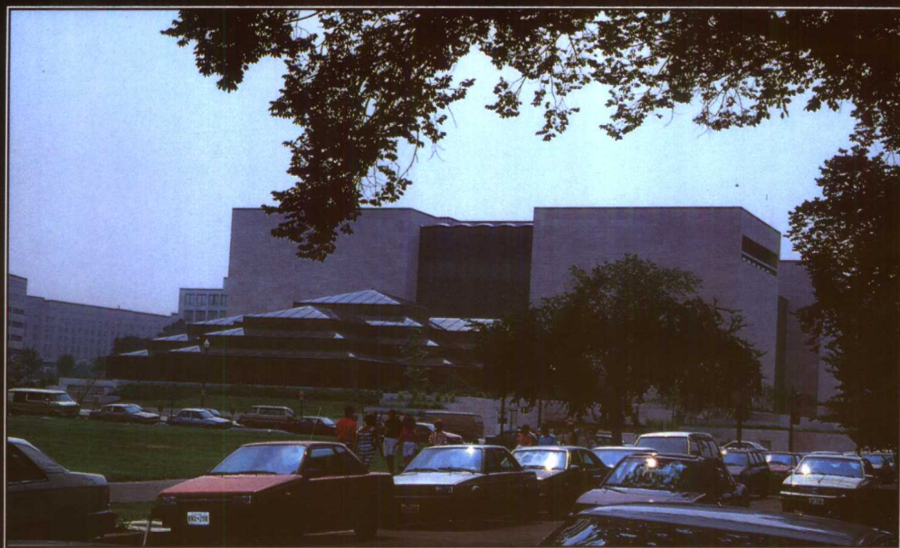
1-1 华盛顿航天博物馆东立面,斜玻璃屋面的是餐厅
