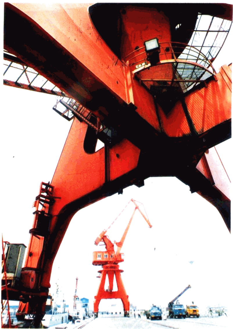
正在建设中的北方大港——京唐港。
