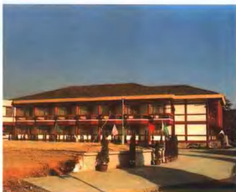
新楼山头平地客房楼
