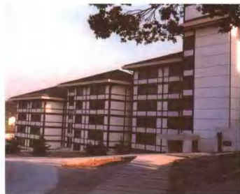
新樓北面（背面外觀）
