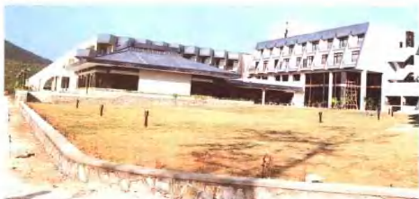
大餐厅及部分客房楼外貌
