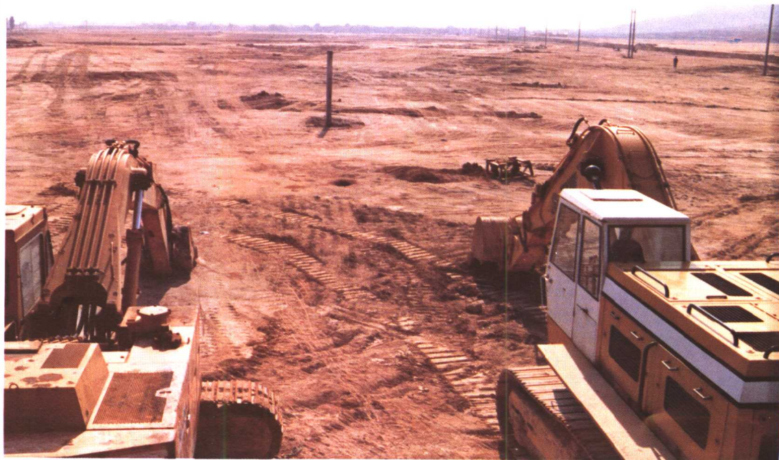
厦门海沧台商投资区建设工程正紧张进行中。截至1990年底，66公顷生活区已实现“三通一平”
