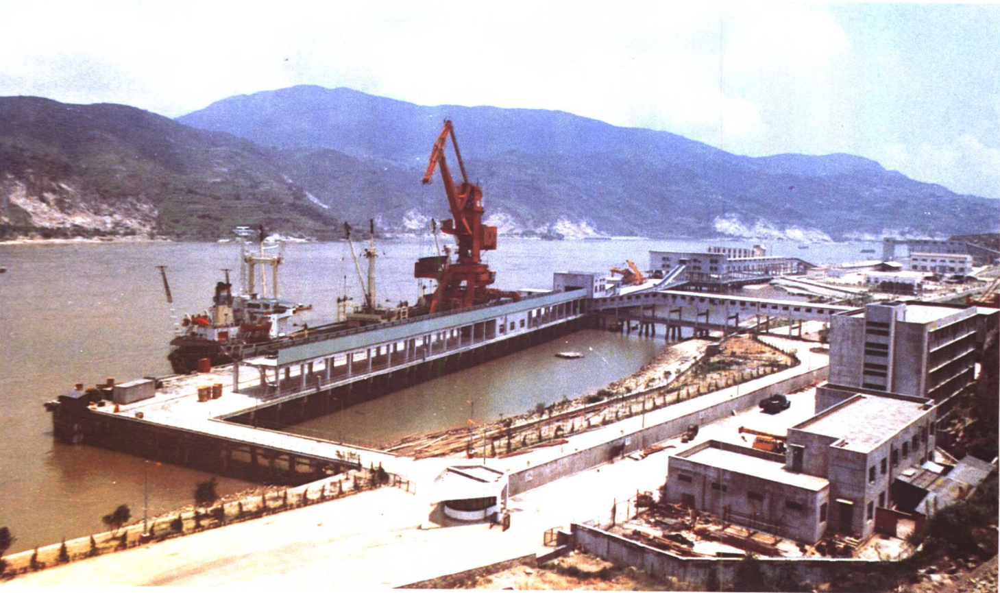
重点建设项目之一——福州煤码头工程已建成投产。
