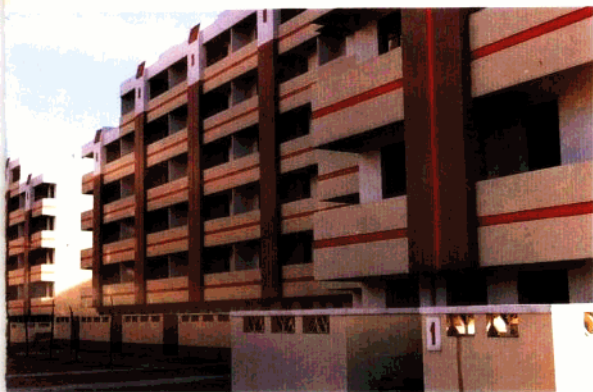
新建的张西职工住宅楼
