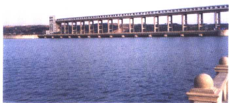
绵阳市三江闸坝
