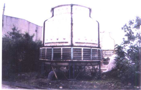
绵阳市东材厂的中水 处理装置
