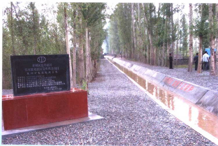
张掖市甘州区盈科灌区黑河流域灌区节水改造项目盈四分渠改造工程
