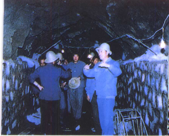
▲ 县委书记张树仁（右1）与施工干部群众研究隧洞科学施工问题。
