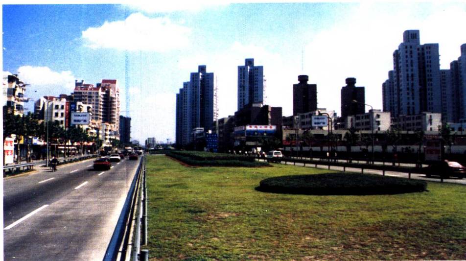
张杨路共同沟内各种管道井然有序
