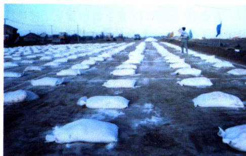
远东大道石灰土层施工
