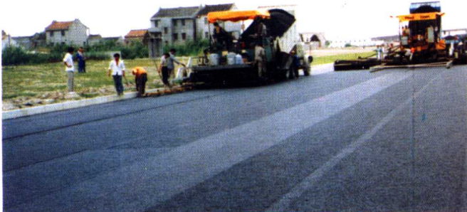
远东大道沥青路面摊铺、碾压施工现场
