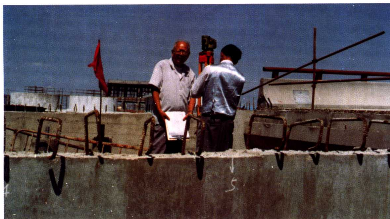
测量专家同济大学测量系王彦斌教授在龙东大道施工现场指导桥坡沉降的跟踪监测工作，确保了桥坡沉降长期观测工作的高质量完成
