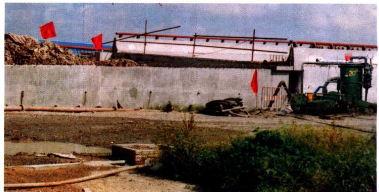
真空井点降水设备及桥坡降水预压现场
