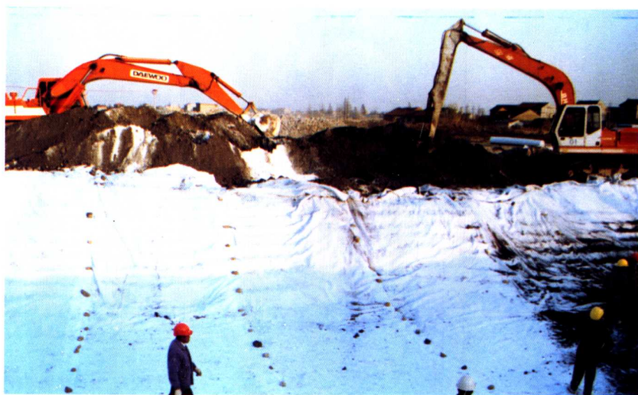
远东大道土工布二灰填浜新技术
