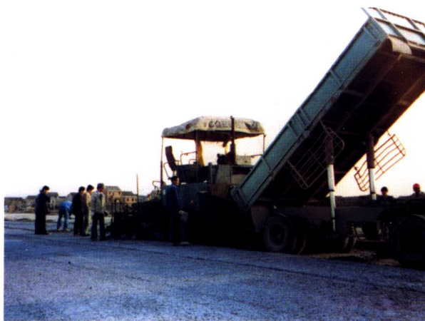
远东大道机械摊铺小粒径三渣
