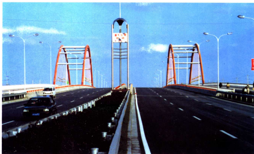
浦东运河大桥钢管混凝土拱桥宛如四道彩虹镶嵌在龙东大道上
