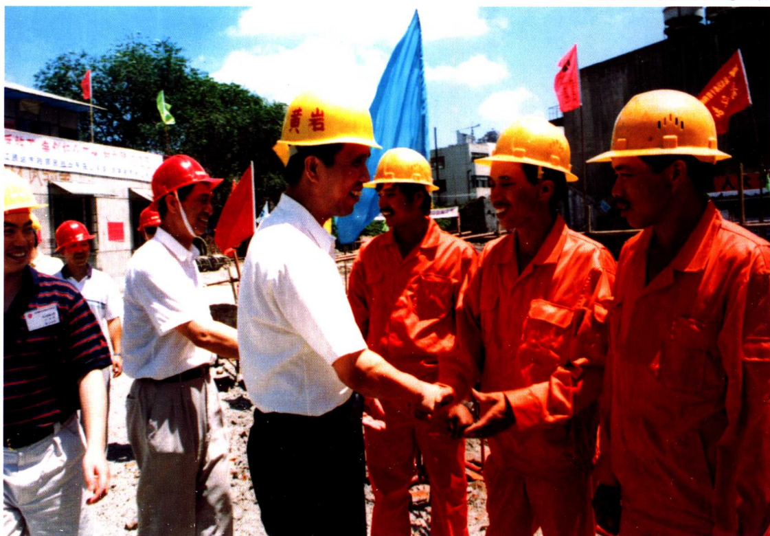
周禹鹏副市长慰问建设者
