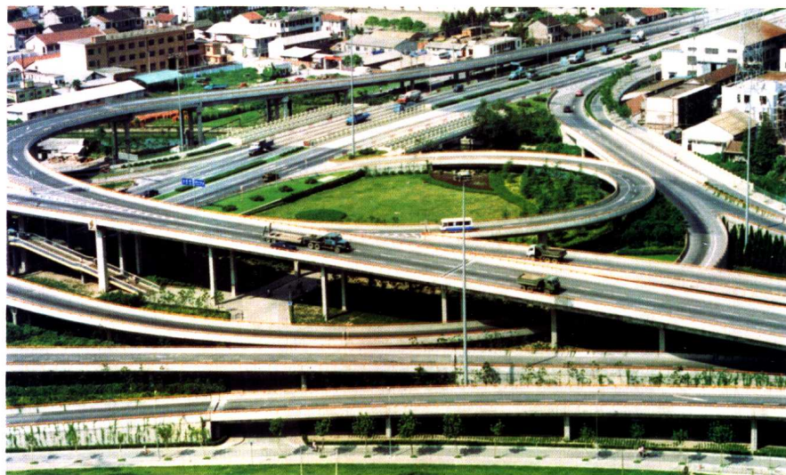
金桥立交全景
