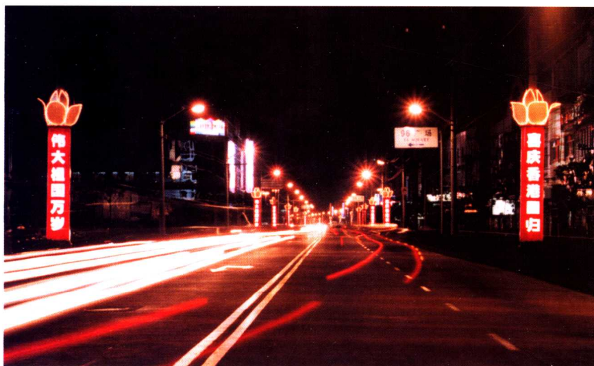
采用钢纤维混凝土新技术施工的东方路夜景
