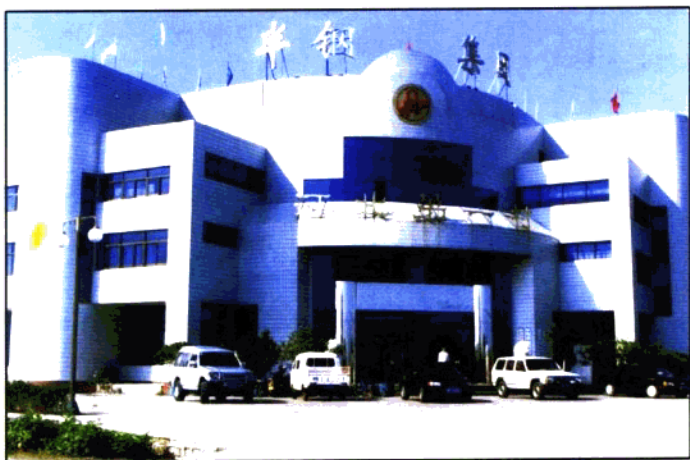
河北唐山半壁店钢铁集团公司。
