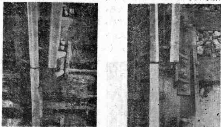
圖4 自动塞鉄塞入楔牢的情况
