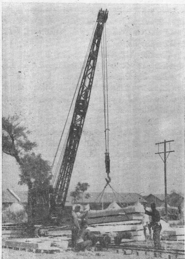
圖 5 用吊車將預製之構件吊起，放在平板礦車上，運往安裝地點
