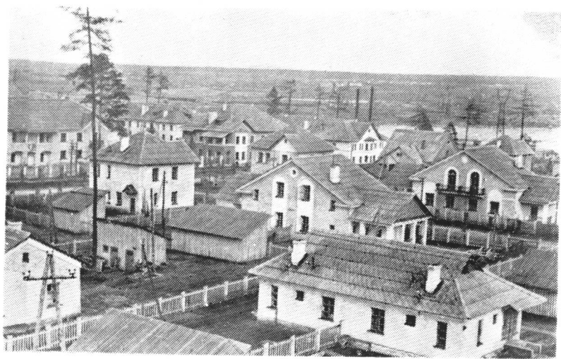
卡瑪水电站建設者的居住区全貌。
