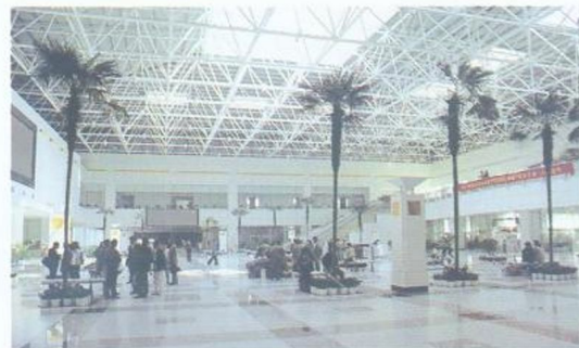
图1-27 珠海机场候机楼内景
