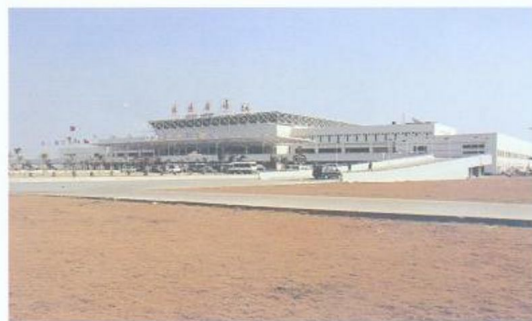
图1-26 珠海机场候机楼外景
