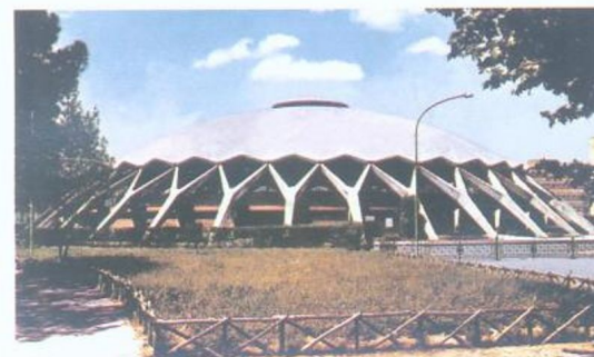
图1-34 罗马小体育馆外景
