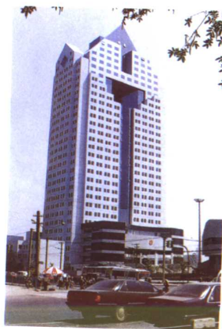
▲杭州市政府大楼基础工程
