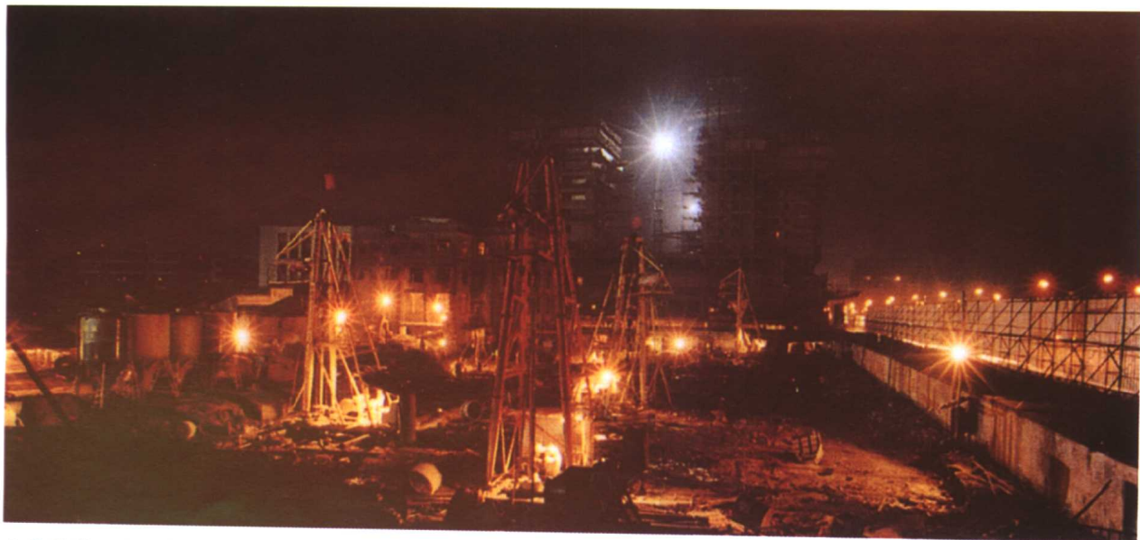
▲沸腾的工地之夜
