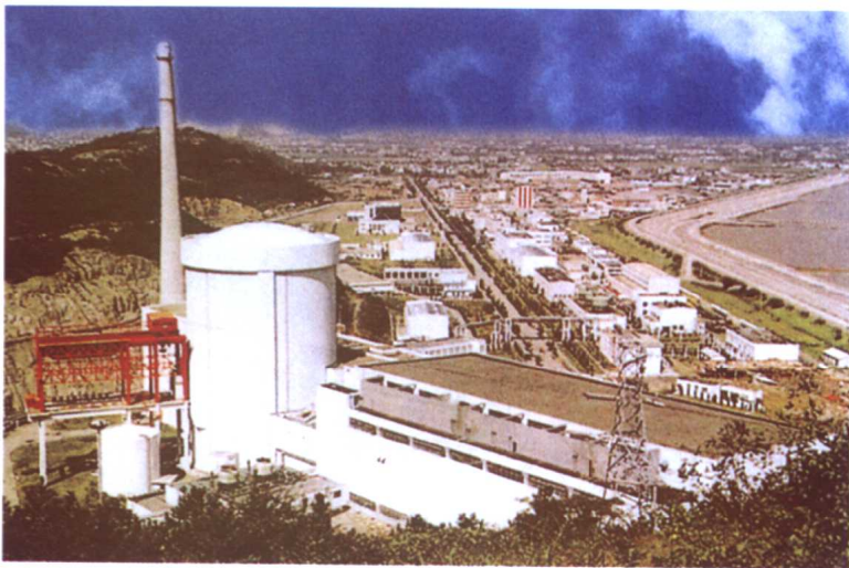
▲中国第一座核电站——秦山核电站其一、二、三期工程物探选址、地下水勘查和评价,由省物勘院、省水文工程地质大队承担
