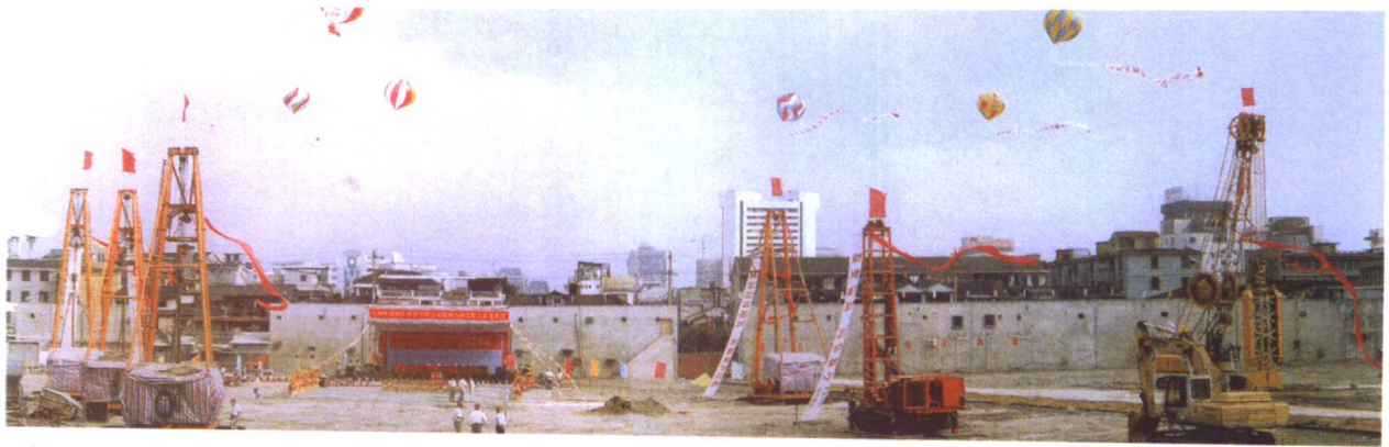
▲杭州西湖国际饭店基桩工程施工全景
