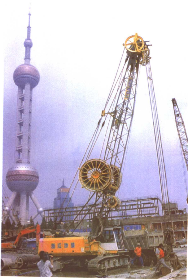
▲上海浦东交通银行大厦地下连续墙成槽
