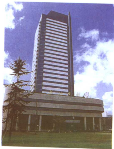
▲浙江日报新闻大楼基础工程
