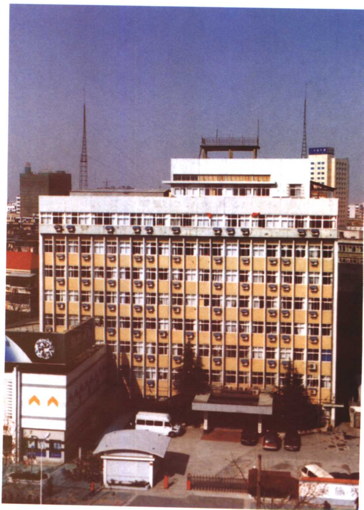
▲浙江省国土资源厅、浙江省地质勘查局办公大楼
