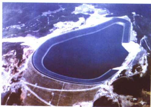
▲天荒坪抽水蓄能电站上水库工程,由华东勘测设计研究院勘察设计
