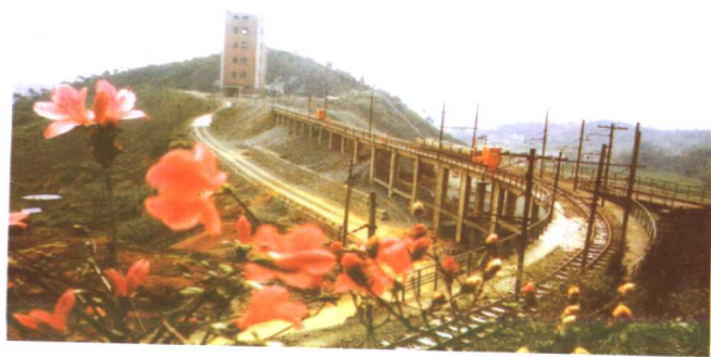
▲绍兴平水铜矿井塔楼和原矿运输线
