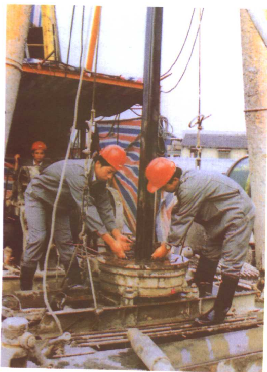
▲灌注桩施工场景
