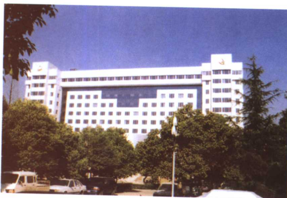
▲省府3号楼基础工程
