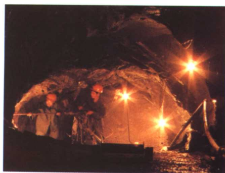
▲坑探工人在井下作业
