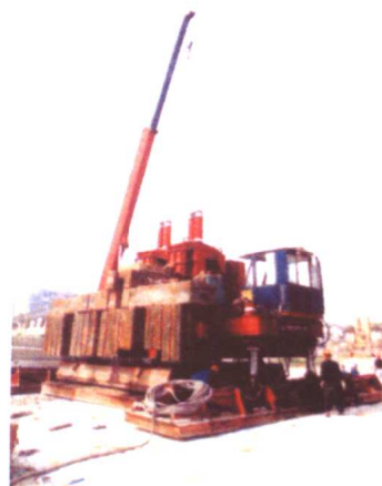
▲杭州涌金广场的静压桩施工
