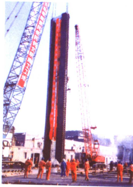
▲杭州凯悦大酒店地下连续墙钢筋笼实放场景
