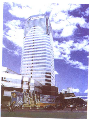
▲浙江省建行大楼基础工程
