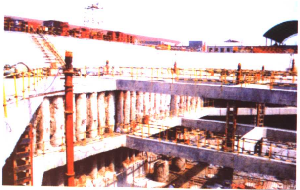
▲杭州第一高楼省长途电信枢纽楼基桩围护
