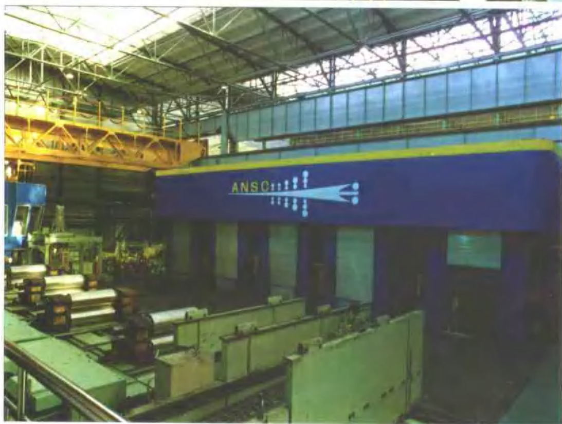
鞍钢冷轧 酸洗生产 线
