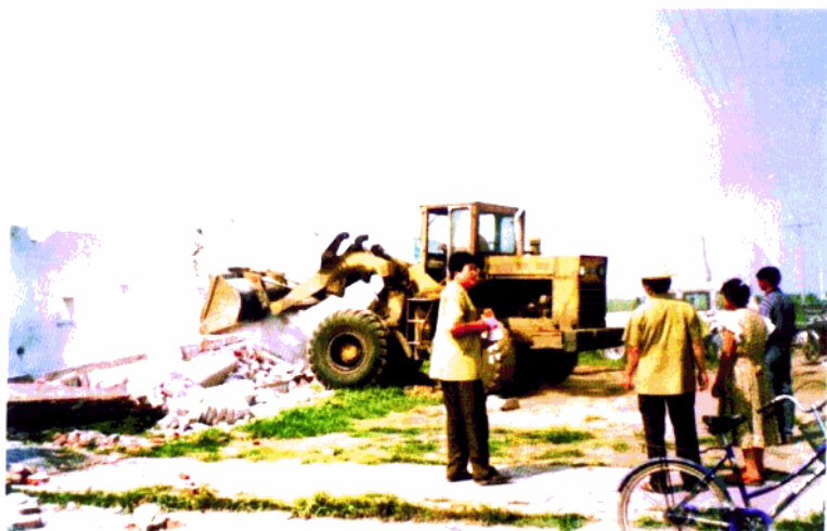
拆除违法建筑
