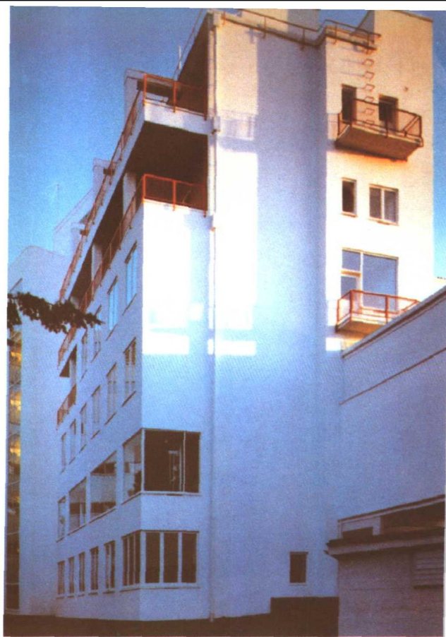
3B 帕米欧疗养院背面
