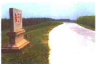
荆江大堤堤顶建设
