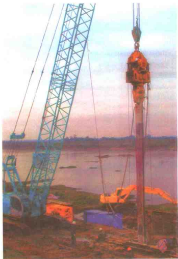
板桩墙法双膜注施工。
