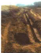
正在荆南新堤段施工
