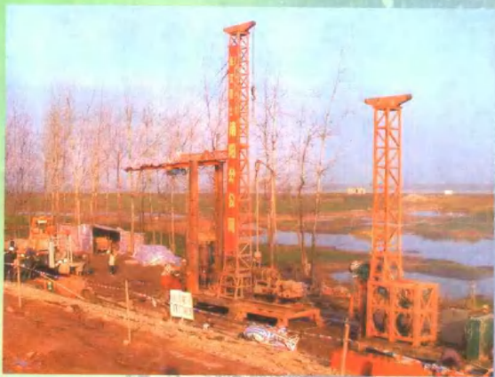
自行研制的LG-2型数显自控拉槽机在长江耙铺大堤进行防渗墙施工。
