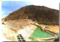
建设中的昌马水库枢纽工程
