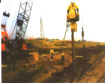
长江荆州大堤钢板桩防渗施工。
