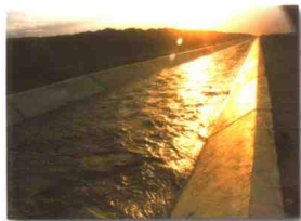
全长 49 公里的昌马西干渠全线建成运行
