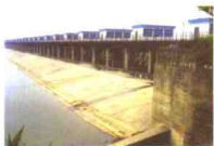
加固后的荆江分洪工程泄洪闸
