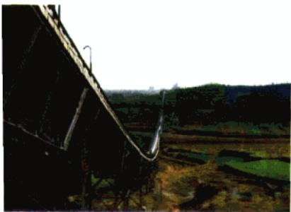
冀东水泥厂8.4公里石料运输线
