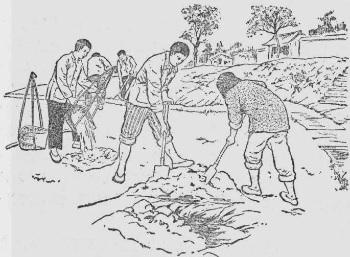
圖7 填平水坑、窪地，疏通溝渠
