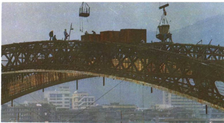
▼用吊斗运送混凝土混合料浇筑底板及下侧板混凝土
