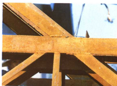
◀已焊成变宽度钢骨架的节点
