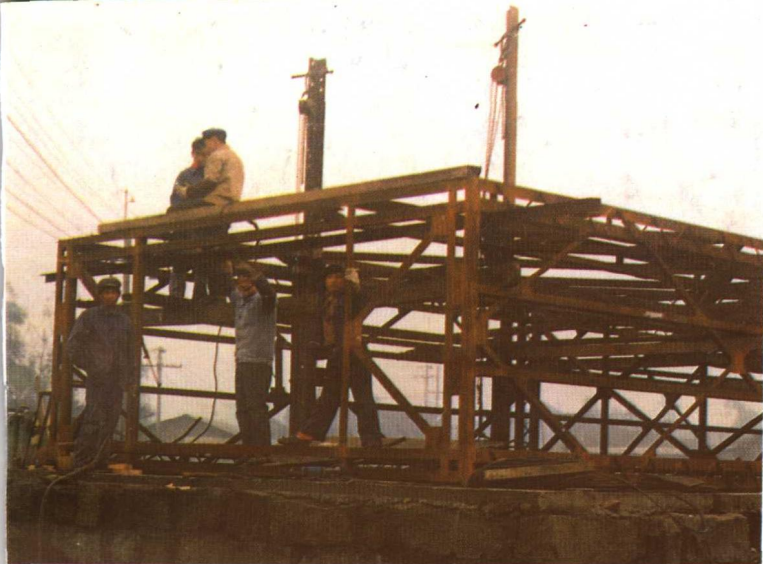
▲ 拱肋钢骨架分段接头处
