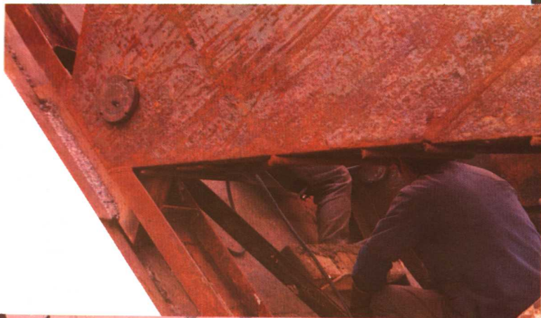
▲吊装第一段钢骨架，用塔扣固定
