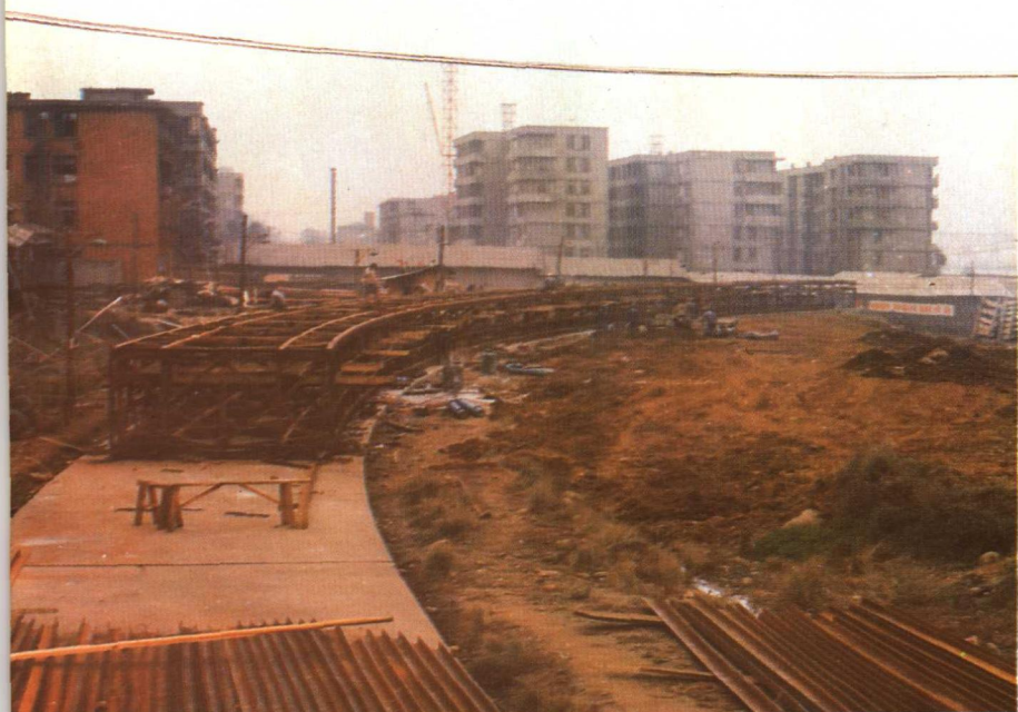
▲ 一条拱肋钢骨架分七段制造
