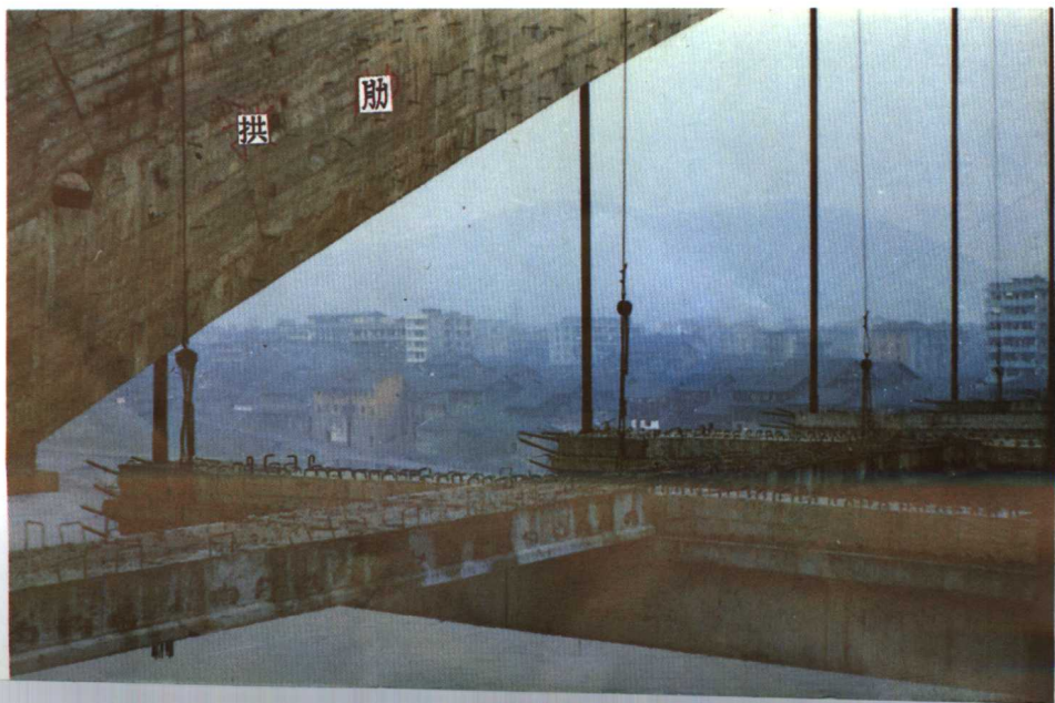
▼安装行车道板时，系吊钢丝绳临时保证纵向稳定
