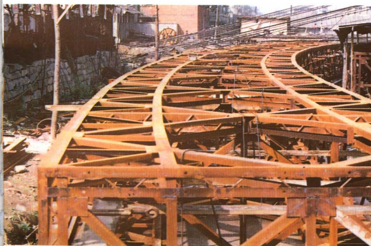
▲ 拼装完毕的一段钢骨架
