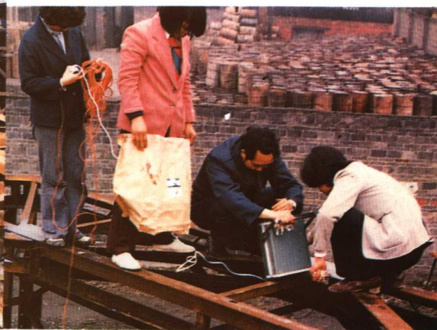
▲ 对钢骨架主要接头焊缝拍片检查
