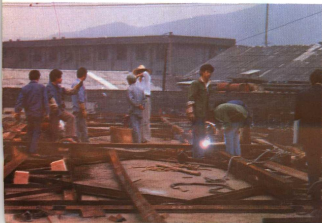
▼ 拱肋钢骨架拼装，侧卧第一层
