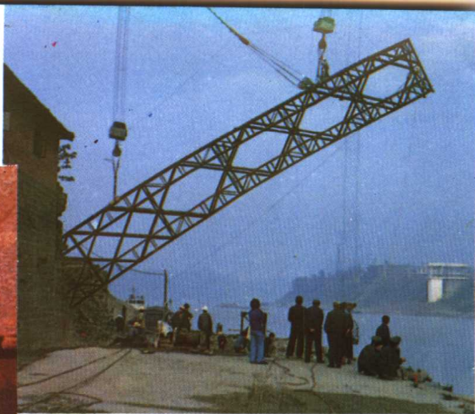
▲吊装第一段钢骨架，用塔扣固定
