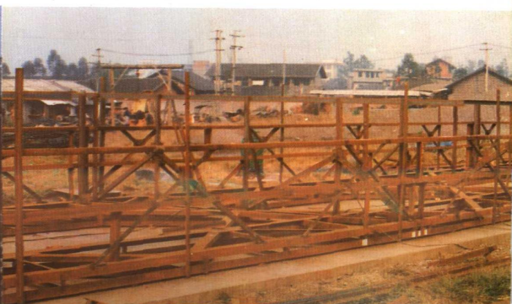
▼ 拱肋钢骨架拼装，侧卧第 2 ~ 4 层
