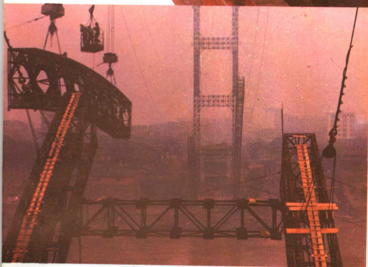
▲两肋钢骨架间加临时横向联结
