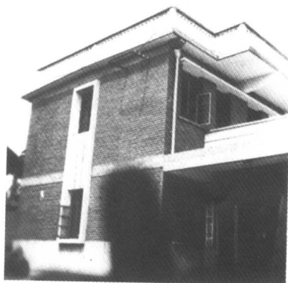
3. 溧阳上沛银行 1978 年新建大楼有抗震设施震后完好
