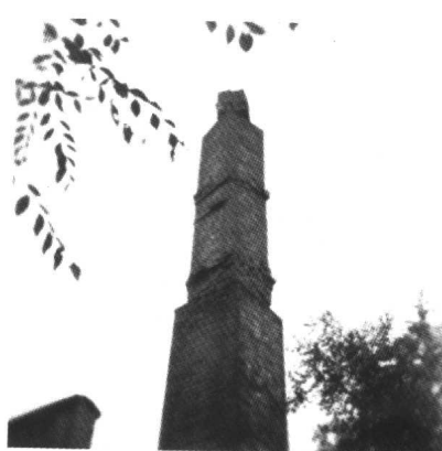
4. 溧阳上兴浴室烟囱水平断成三截,顶部右旋 45°
