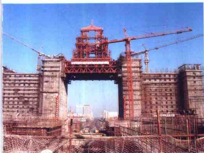
○由建工集团承建的西客站工程，正在提升 1800 吨的西客站主站房钢架结构。
