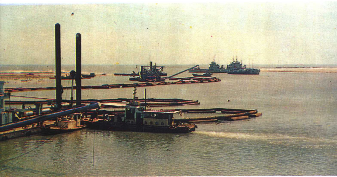
大型绞船开挖港池航道
