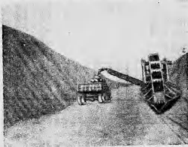
圖6. 用側溝開挖機修築路堑側溝
