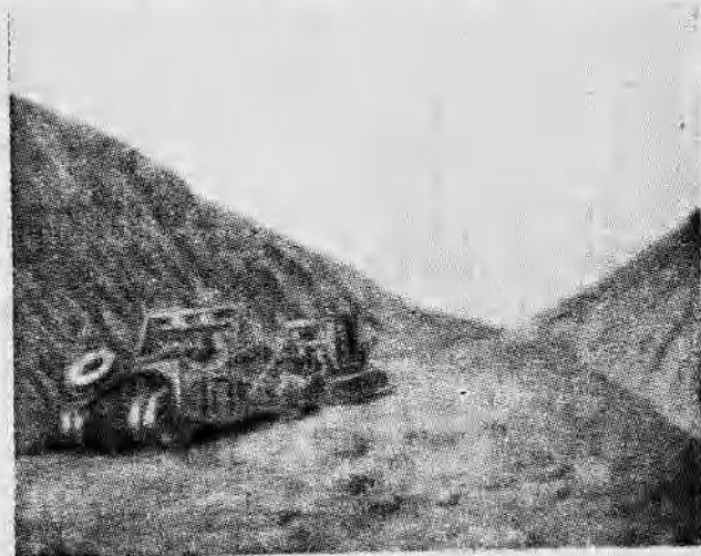
圖4. 用Д-147型縫道機修理探險道的基面
