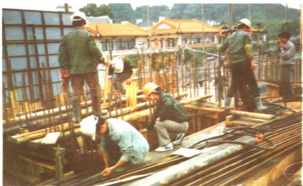
福州建筑工程职校学生在工地实践
