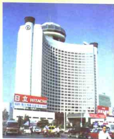
防水施工样楼：国际饭店
