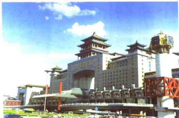
西客站工程利用本厂外加剂施工
