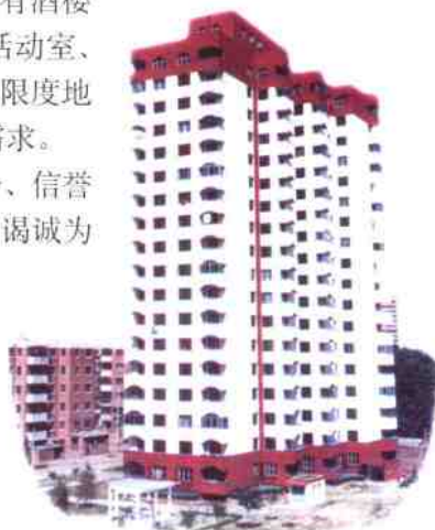
国优工程玉林小区29号楼
