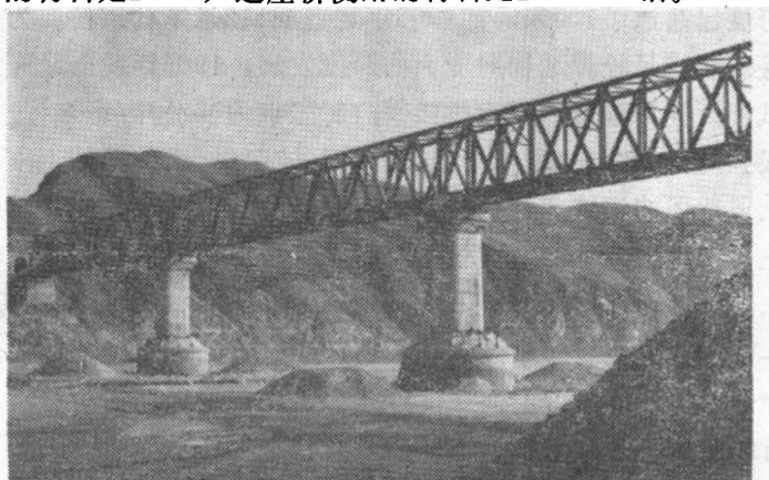
照片 1—3 跨度为 3 \times 128 米连续桁梁桥
