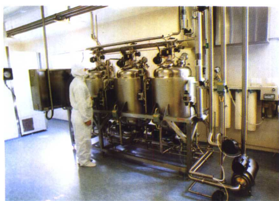
基因工程药物 GMP 中试车间
