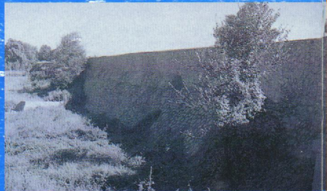
日伪时期修建的田家庄节制闸（1919年）
